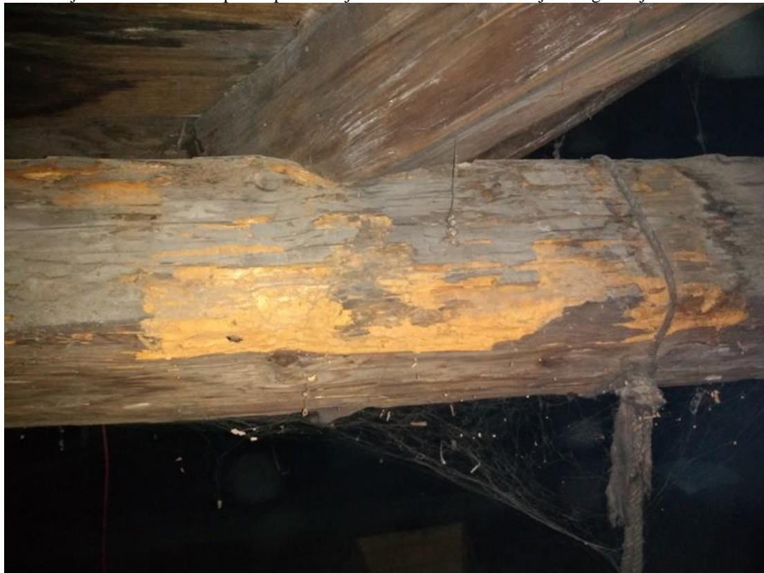
4.11 Miejscowe uszkodzenie styku pęczki po rednich wskutek działania korozji biologicznej na pograniczu skrzydła wschodniego i północnego (równoległego do ul. Kopernika) - odcinek C
