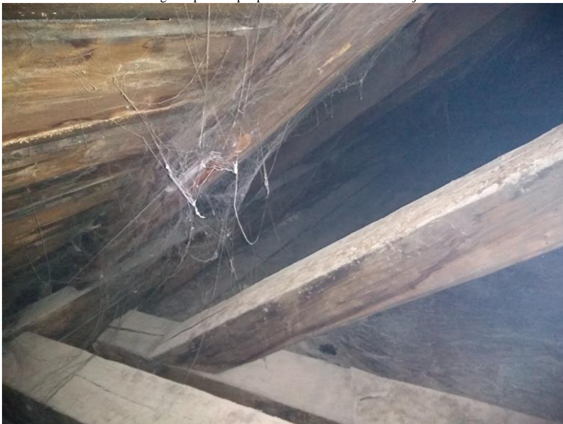
4.5 Widok wewnątrz dachowego w pobliżu podparcia na ścianie zewnętrznej - odcinek C
