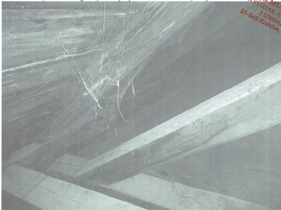
4.5 Widok więzara dachowego w pobliżu podparcia na ścianie zewnętrznej - odcinek C
