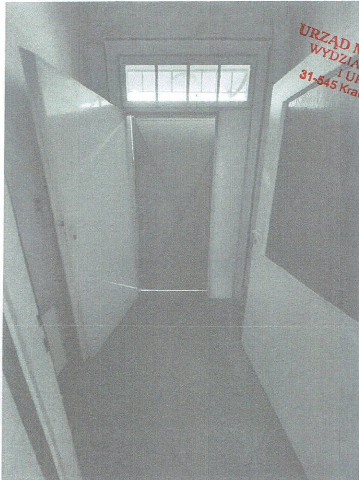
Zdjęcie 4. Podwójne drzwi stanowiące ewakuację do wymiany
