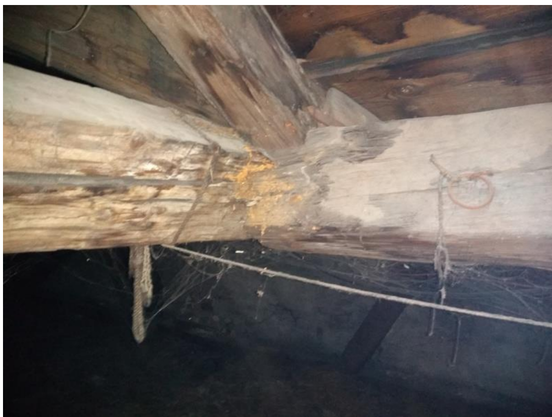
4.11 Miejscowe uszkodzenie styku pęczki po rednich wskutek działania korozji biologicznej na pograniczu skrzydła wschodniego i północnego (równoległego do ul. Kopernika) - odcinek C
