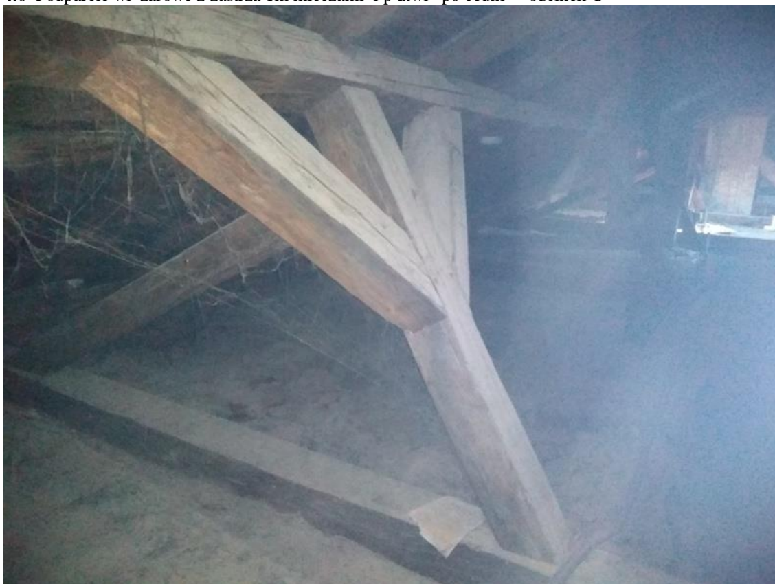
4.6 Podparcie wewnątrz z zastrzałem mieczami i płatwi po rdni - odcinek C
