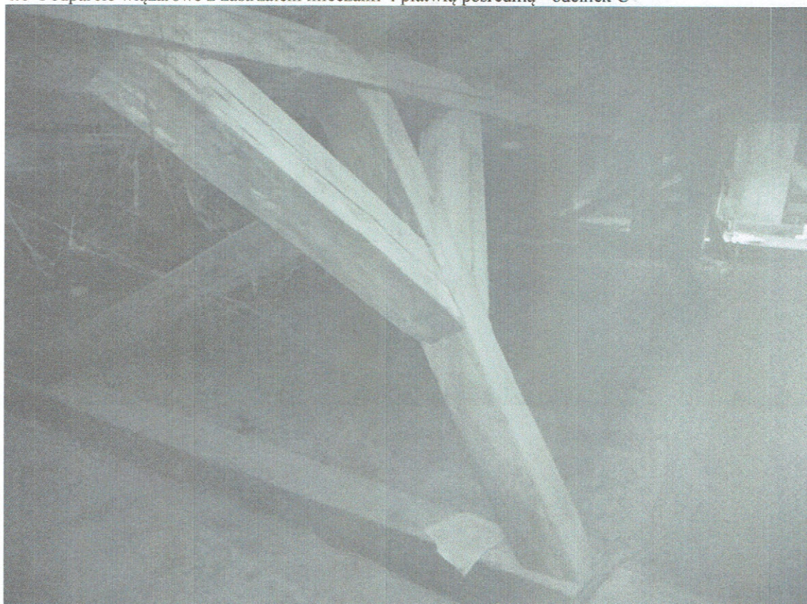
4.6 Podparcie więzarów z zastrzałem mieczami i płatwią pośrednią - odcinek C
