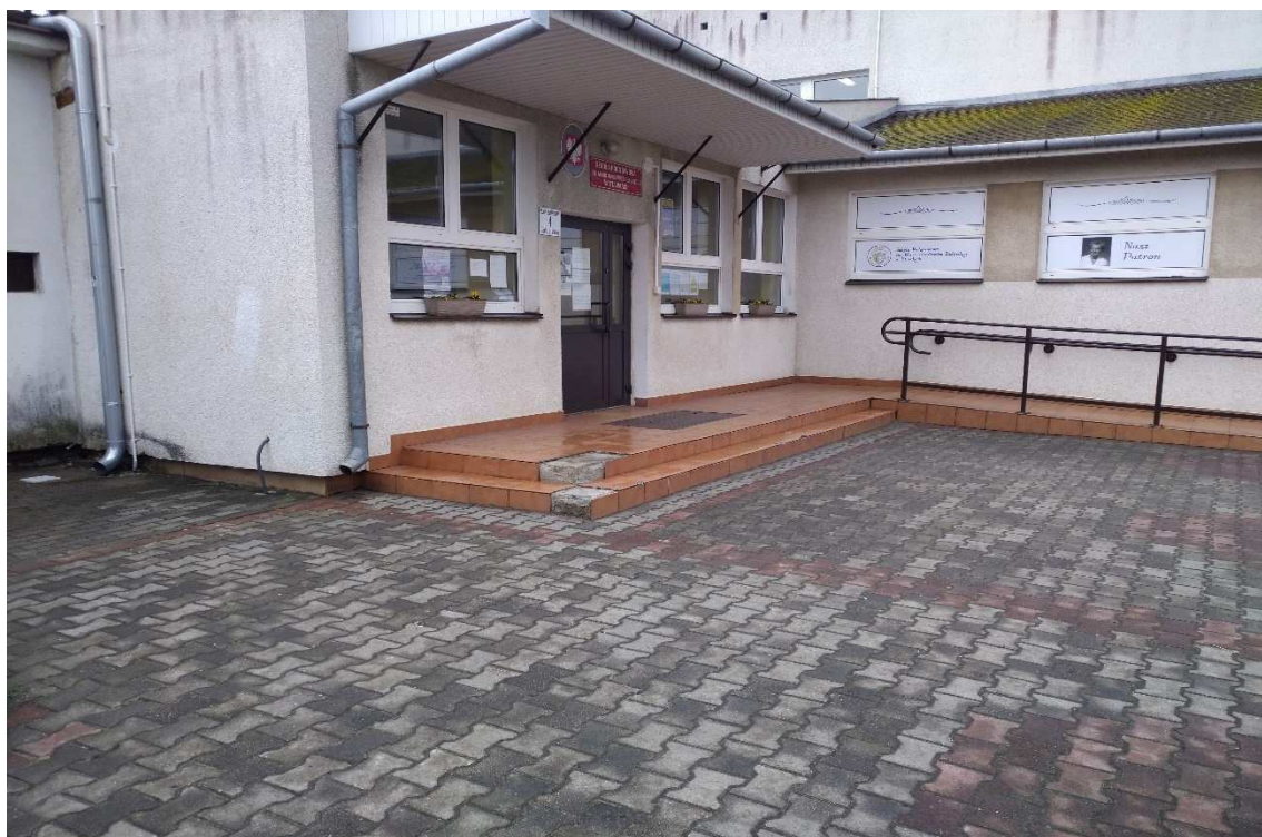
Fot.5, 6, 7. Schody zewnętrzne na elewacji zachodniej do odbudowy i obłożenia oraz stolarka drzwiowa do wymiany
