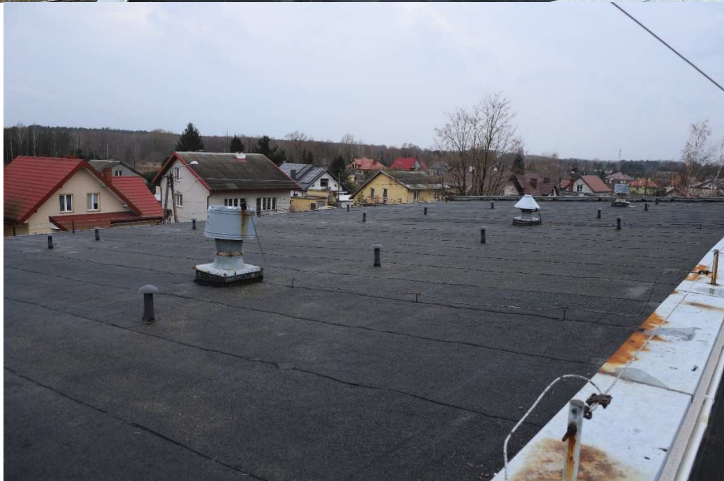
Fot.21,22,23,24,25,26. Cały dach nad szkołą do docieplenia, obróbki blacharskie do wymiany
