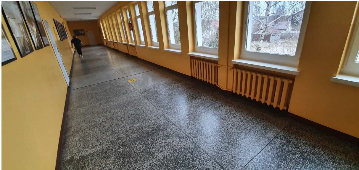
Fot.35. Zastosowanie nakładek parapetowych na wszystkie parapety wewnętrzne
