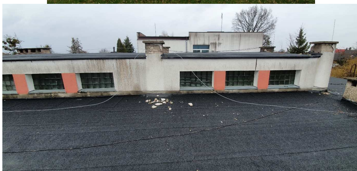
Fot.11,12. Luksfery na klatce schodowej oraz nad korytarzem do likwidacji, wymiana na okna (witryny)
