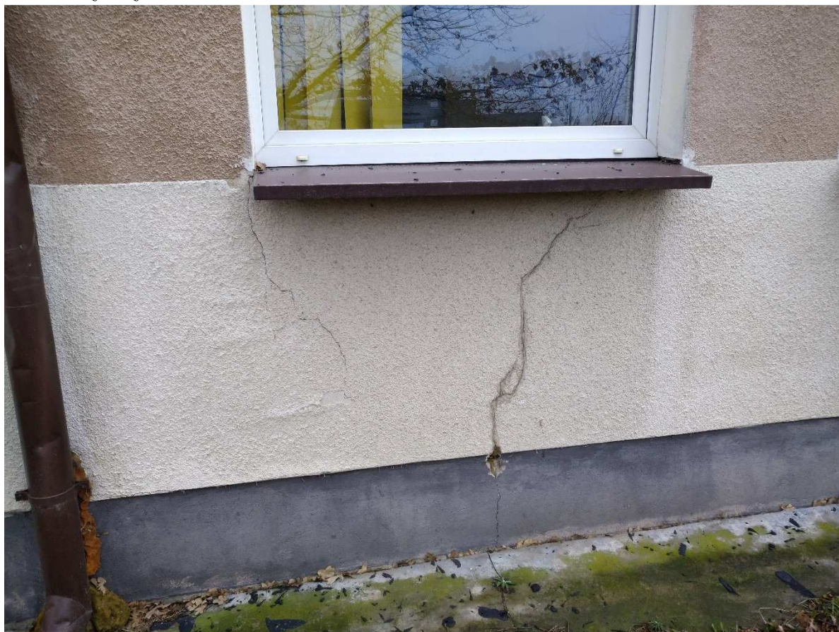
Fot.2. Pęknięcia na elewacji
