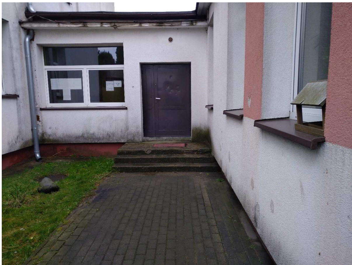
Fot.5, 6, 7. Schody zewnętrzne na elewacji zachodniej do odbudowy i obłożenia oraz stolarka drzwiowa do wymiany
