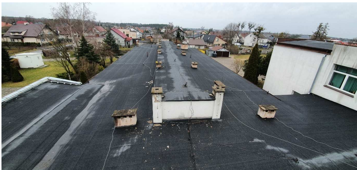
Fot.19,20. Remont kominów poprzez uzupełnienie tynków, kratki w kominach, czapek kominowych.
