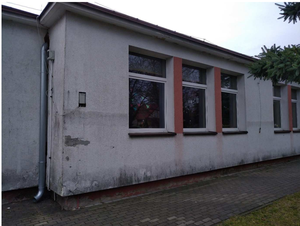
Fot.3. Uszkodzenia elewacji. Wymiana wszystkich parapetów zewnętrznych
