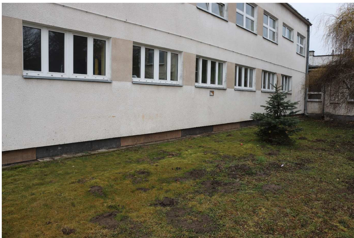
Fot.1. Uszkodzenia cokołu
