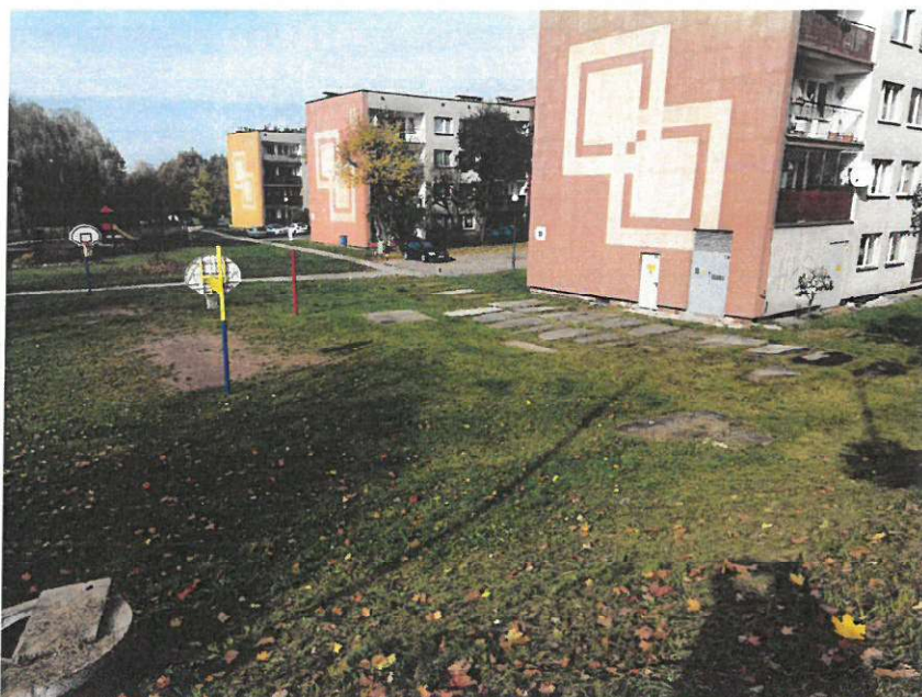
Fot. 9. Widok budynków wielorodzinnych wraz ze stacją Trafo sąsiadujących z przedmiotowym terenem.
