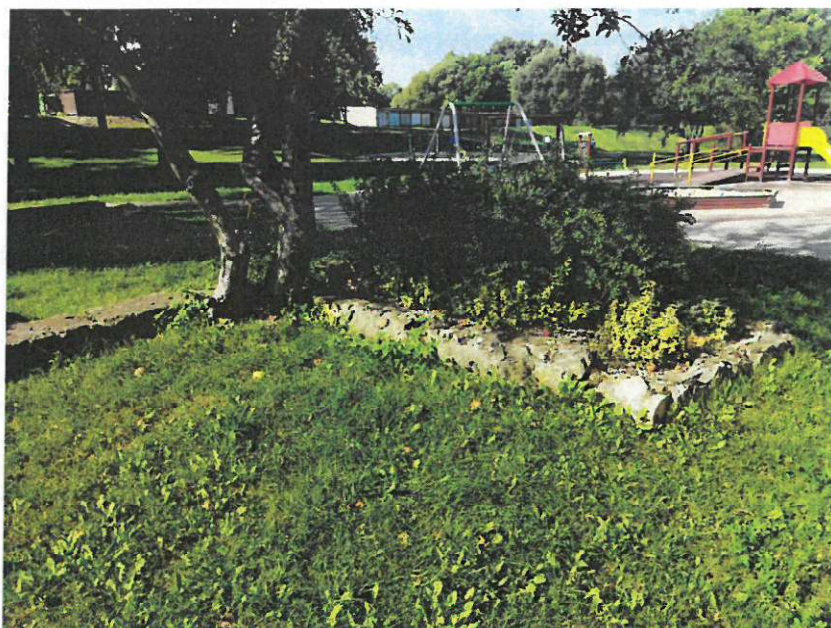
Fot. 5. Widok murowanych pozostałości przeznaczonych do usunięcia.
