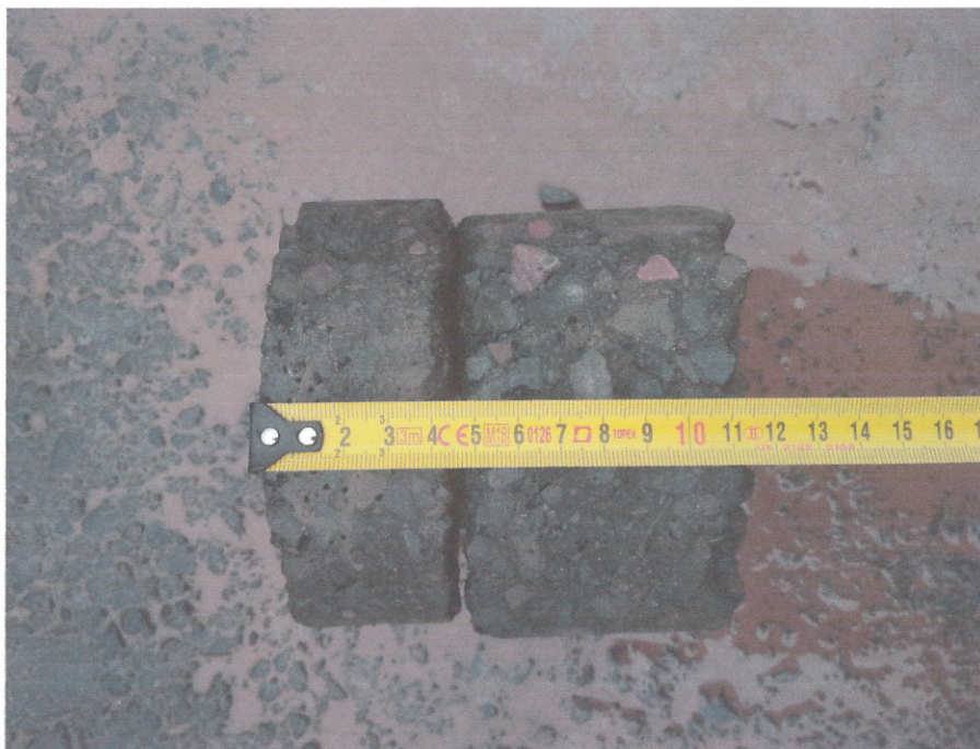
Rys.13 Pomiar rdzenia z otworu nr 13'
