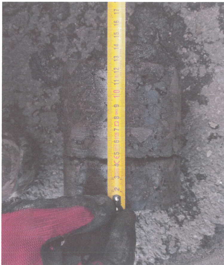
Rys.9 Pomiar rdzenia z otworu nr 9'
