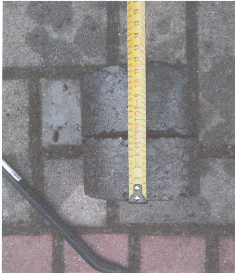
Rys.12 Pomiar rdzenia z otworu nr 12'
