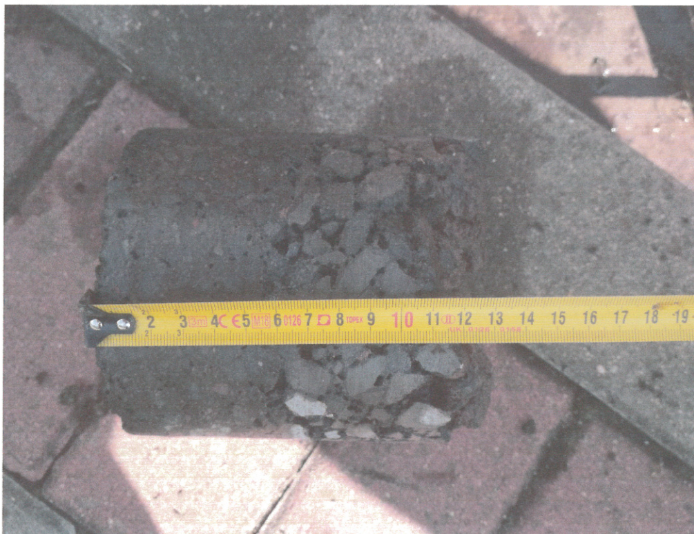
Rys.10 Pomiar rdzenia z otworu nr 10'
