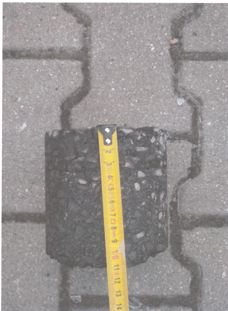
Rys.1 Pomiar rdzenia z otworu nr 1'
