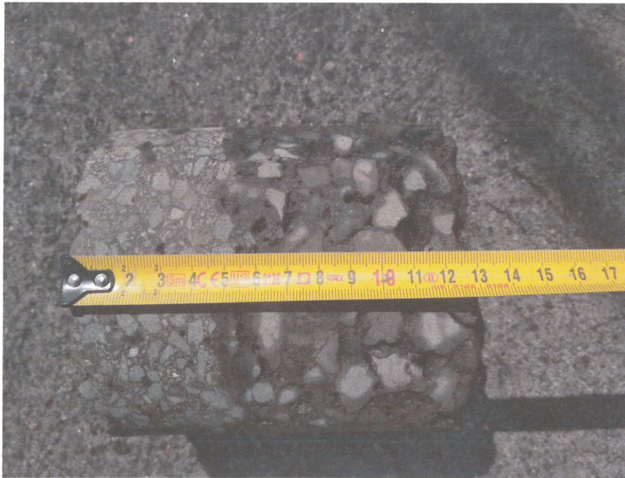
Rys.8 Pomiar rdzenia z otworu nr 8'
