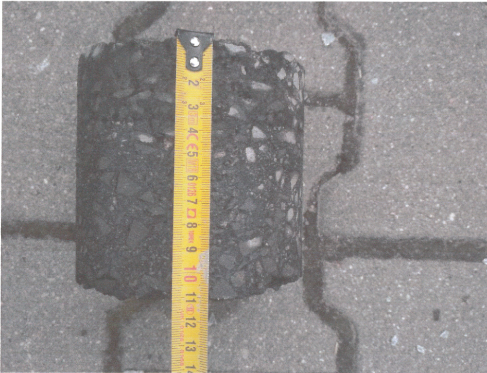
Rys.2 Pomiar rdzenia z otworu nr 2'
