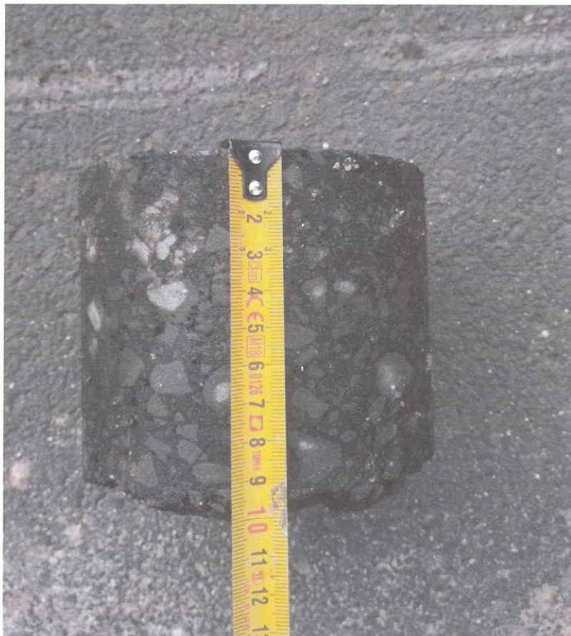
Rys.3 Pomiar rdzenia z otworu nr 3'
