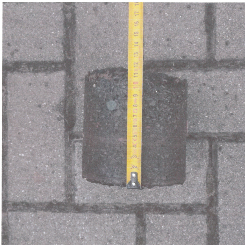
Rys.4 Pomiar rdzenia z otworu nr 4'
