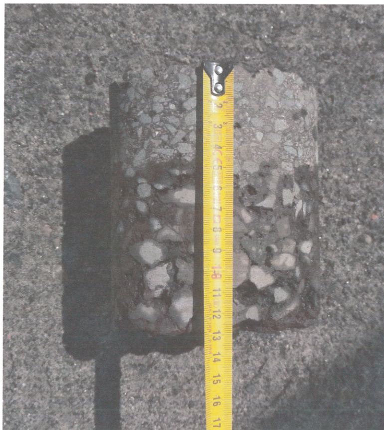
Rys.7 Pomiar rdzenia z otworu nr 7'
