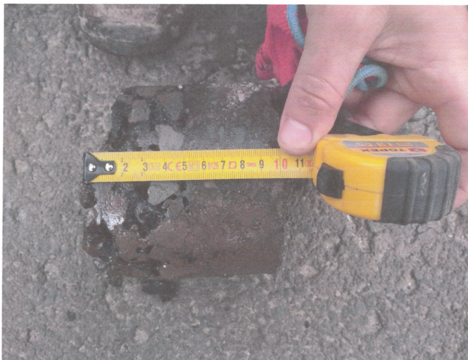
Rys.6 Pomiar rdzenia z otworu nr 6'
