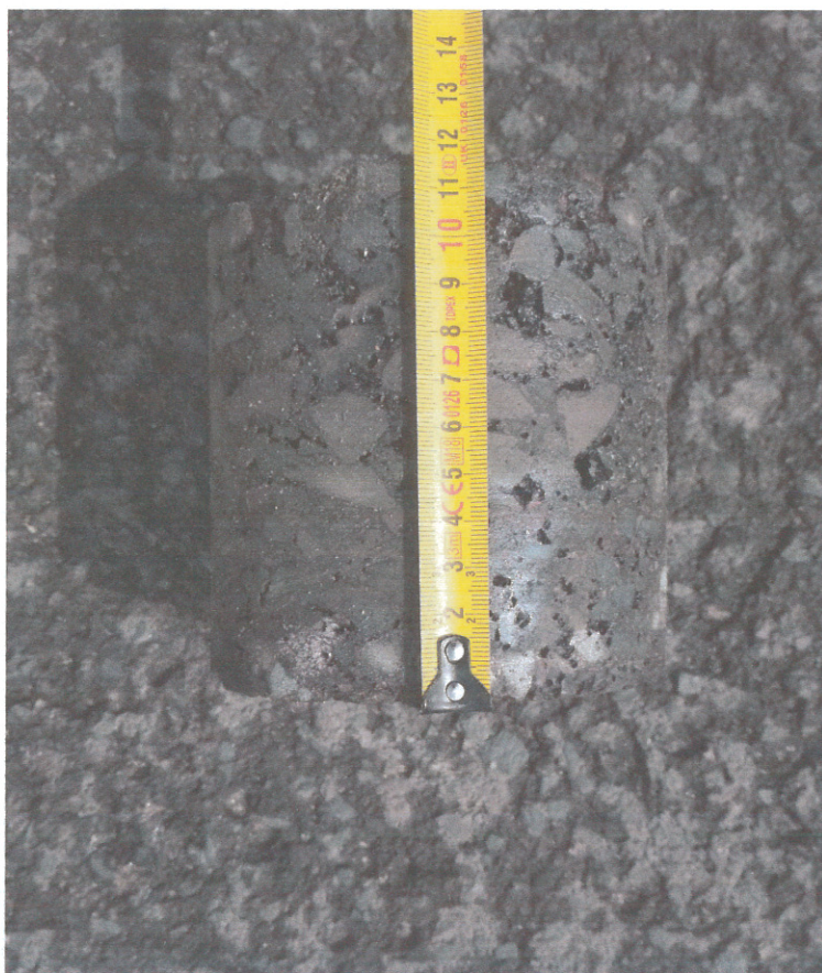
Rys.11 Pomiar rdzenia z otworu nr 11'
