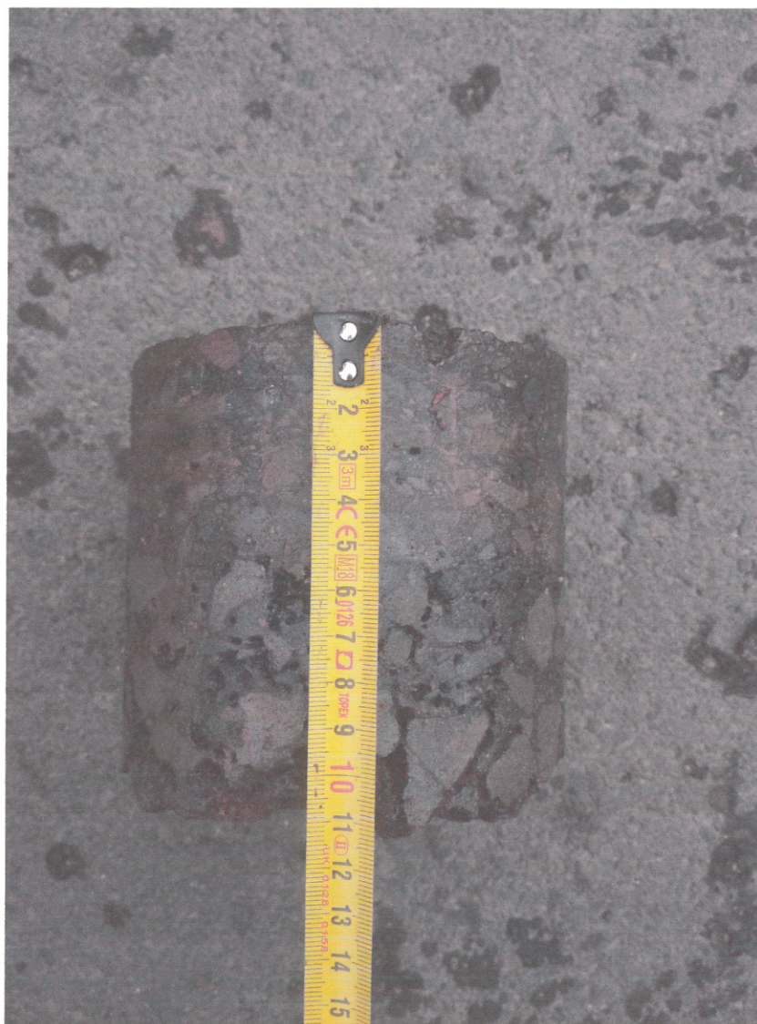
Rys.14 Pomiar rdzenia z otworu nr 14'
