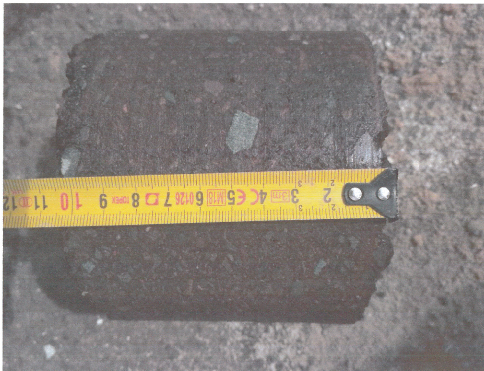
Rys.5 Pomiar rdzenia z otworu nr 5'
