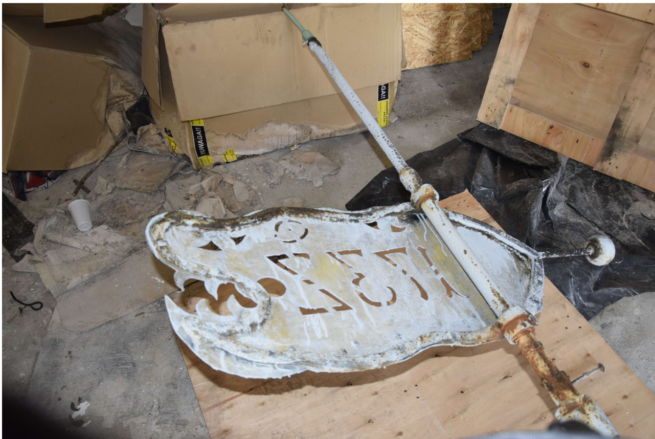
Fot. 18. Zdemontowany szpic iglicy z wiatrowskazem
