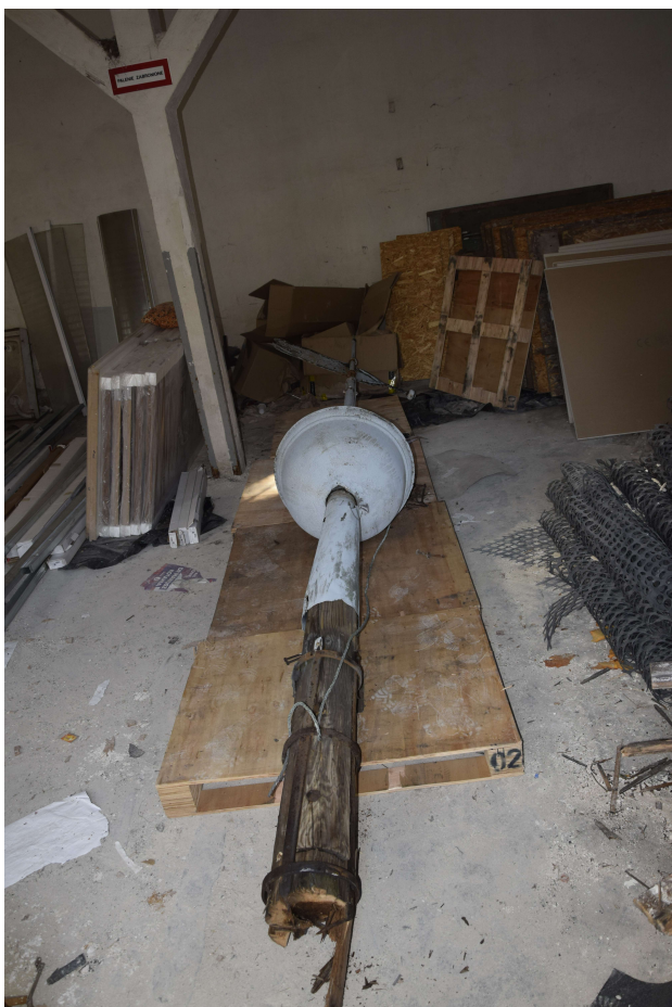
Fot. 16. Zdemontowana uszkodzona iglica
