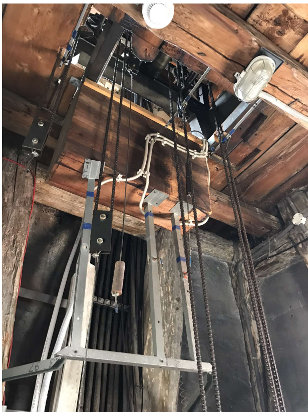
Fot. 10. Mechanizm zegarowy, drewniany strop oraz otwór w stropie.
