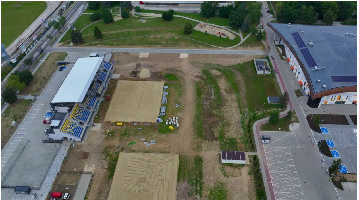
Rys. 2 - Stan po wykonaniu I etapu prac (źródło: http://stadiony.net/w_budowie/pol/stadion_traugutta_tarnow )
