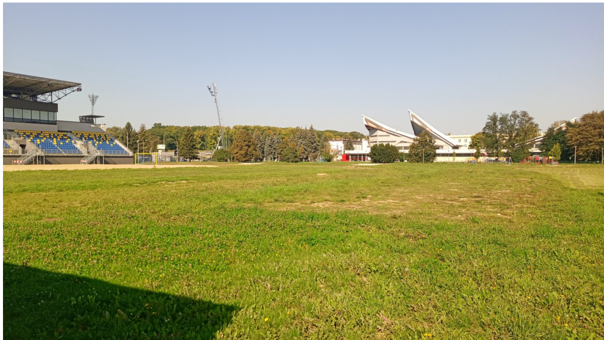
1. Stadion - widok od strony południowej.
