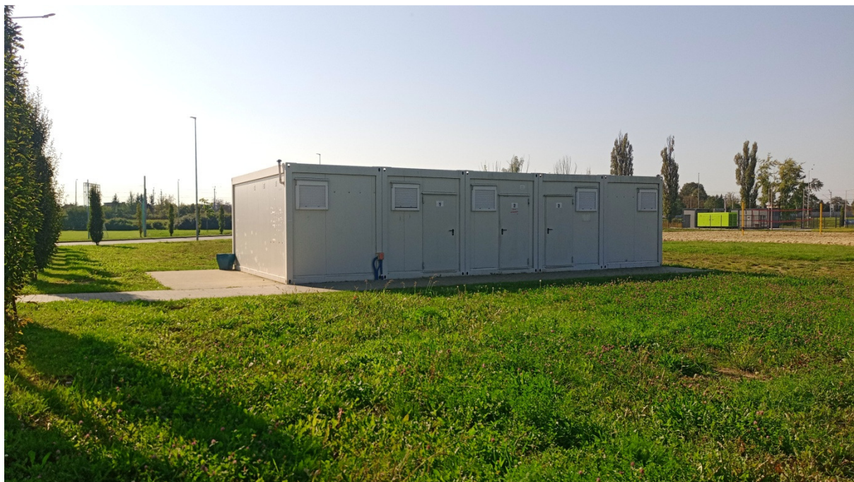
4. Kontenerowe zaplecze szatniowe.
