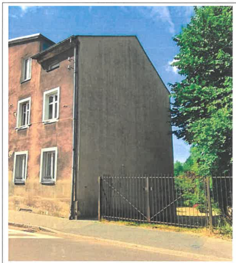
Zdjęcie nr 7 – Elewacja szczytowa – północna – ocieplona warstwą styropianu grubości 10 cm
