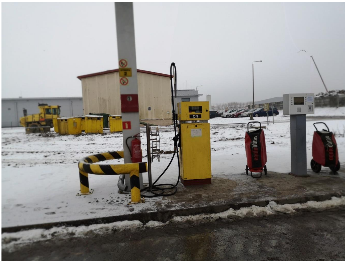
Zdjęcie 3. Stacja paliw płynnych
