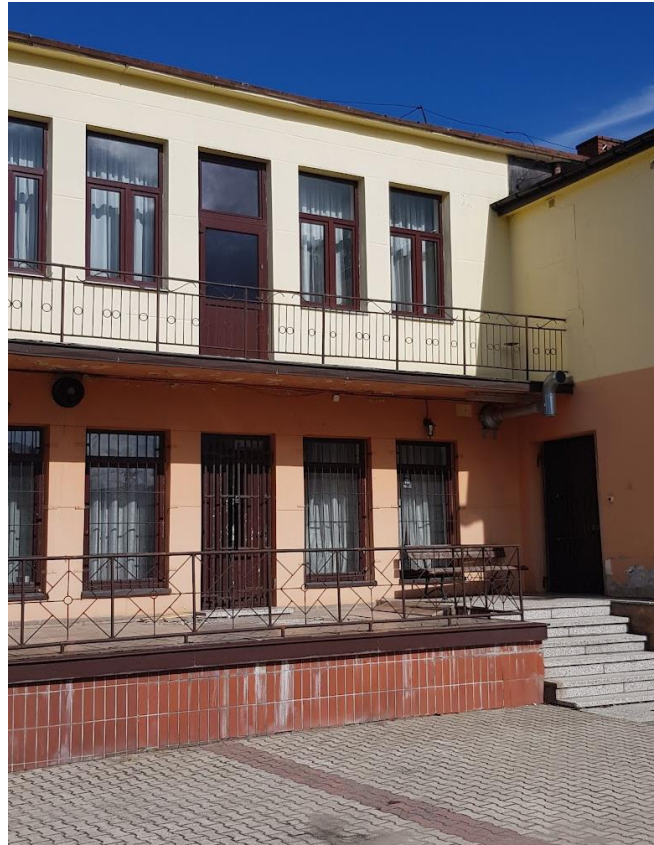
Fot. nr 2. Widok elewacji południowej (frontowej)
