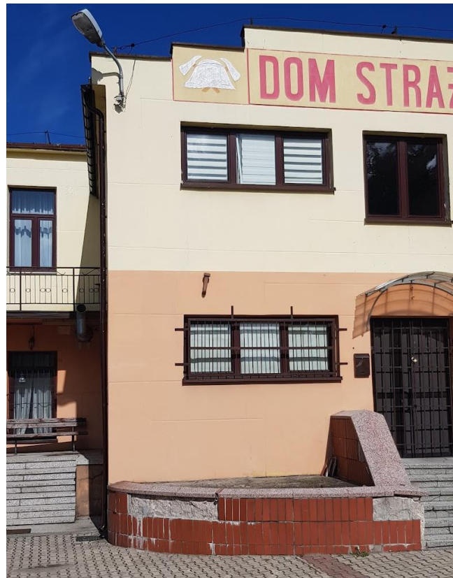
Fot. nr 3. Widok elewacji południowej (frontowej)
