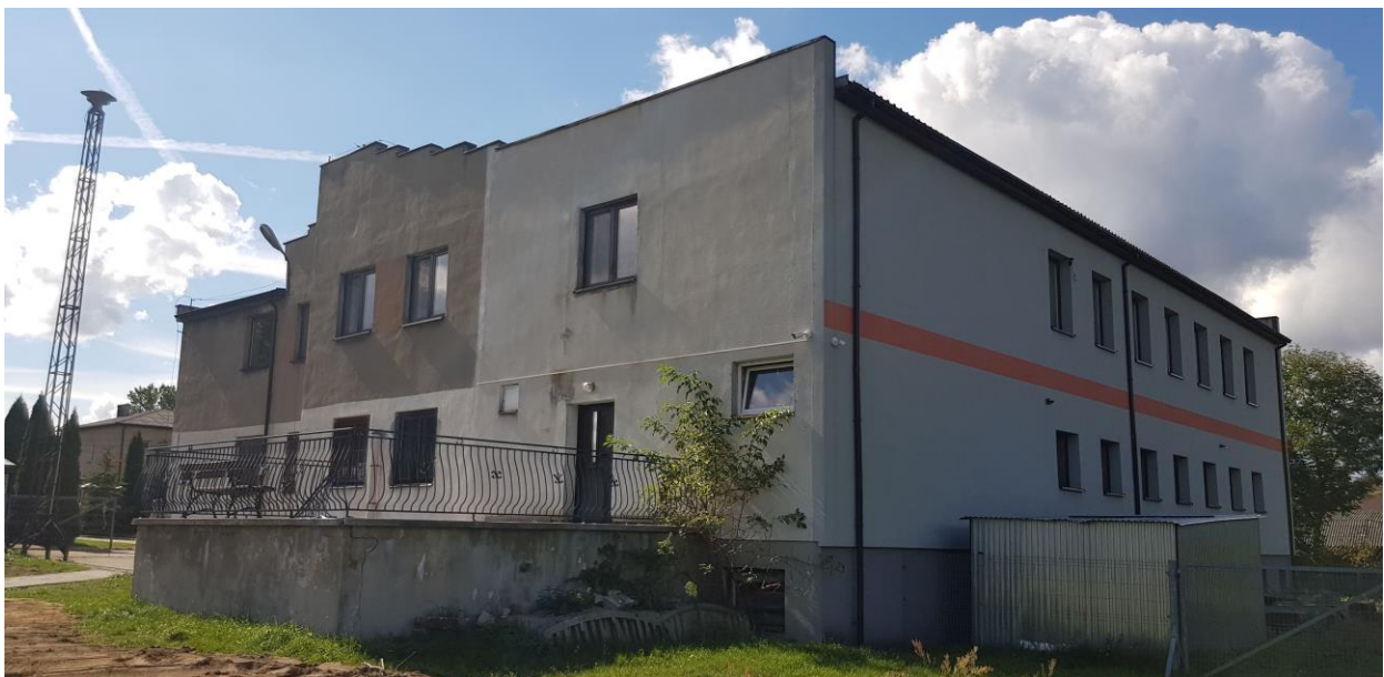
Fot. nr 1. Widok elewacji wschodniej i północnej (docieplona)
