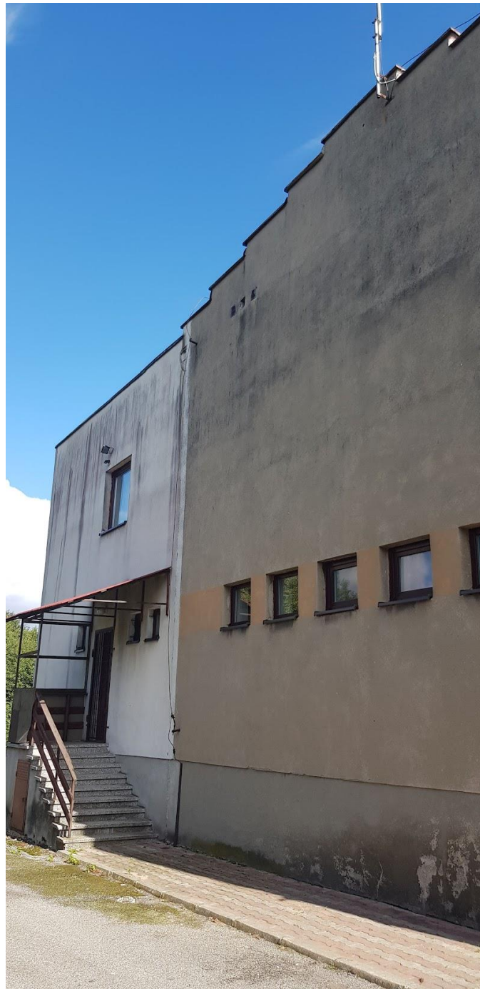
Fot. nr 4. Widok fragmentu elewacji zachodniej
