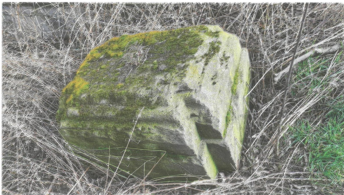
Fot. 4. Województwo dolnośląskie, powiat legnicki, Kościelec, Rzeźba kamienna, wolnostojąca, przedstawiająca św. Jana Nepomucena, część cokołowa, widoczne liczne uszkodzenia, zabrudzenia powierzchni, widoczne warstwy mchu, powierzchnia mocno zdegradowana, K. Łopatowska 2021.
