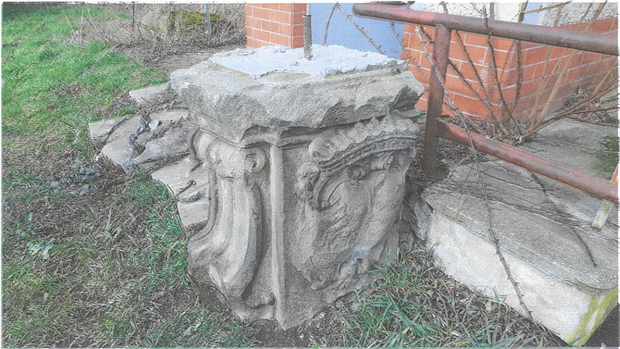
Fot. 5. Województwo dolnośląskie, powiat legnicki, Kościelec, Rzeźba kamienna, wolnostojąca, przedstawiająca św. Jana Nepomucena, część cokołowa, widoczne liczne uszkodzenia, zabrudzenia powierzchni, powierzchnia mocno zdegradowana, liczne uszkodzenia formy rzeźbiarskiej, K. Łopatowska 2021.
