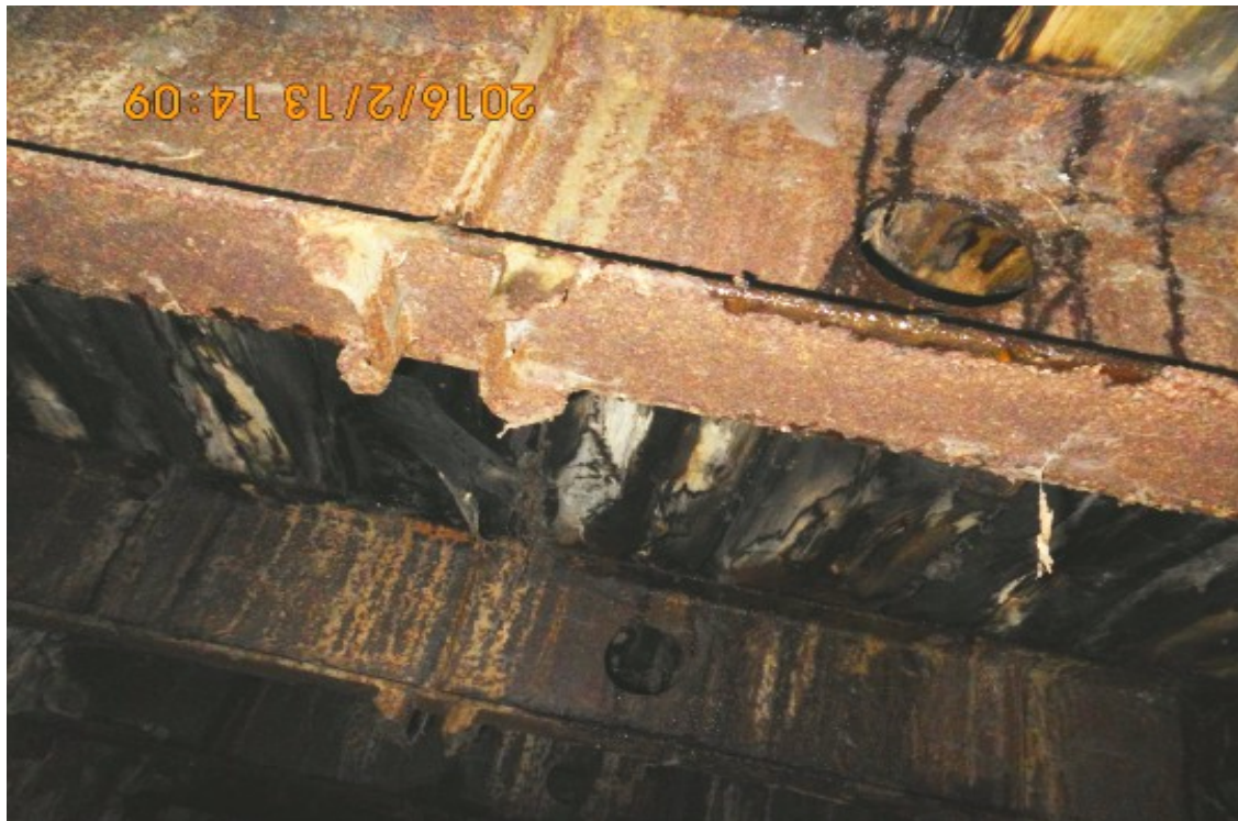
Zdjęcie 3.11 : Widok konstrukcji nośnej od spodu mostu
