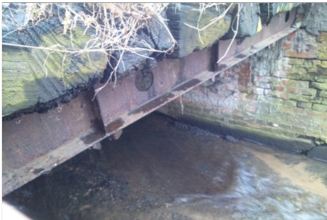
Zdjęcie nr 3.4 : Widok elementów konstrukcji nośnej i pomostu
