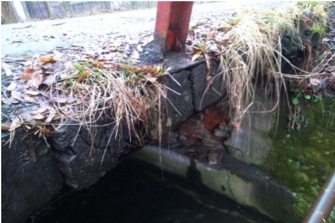
Zdjęcie 3.9 : Szczegół pomostu i zamocowania słupków balustrady.
