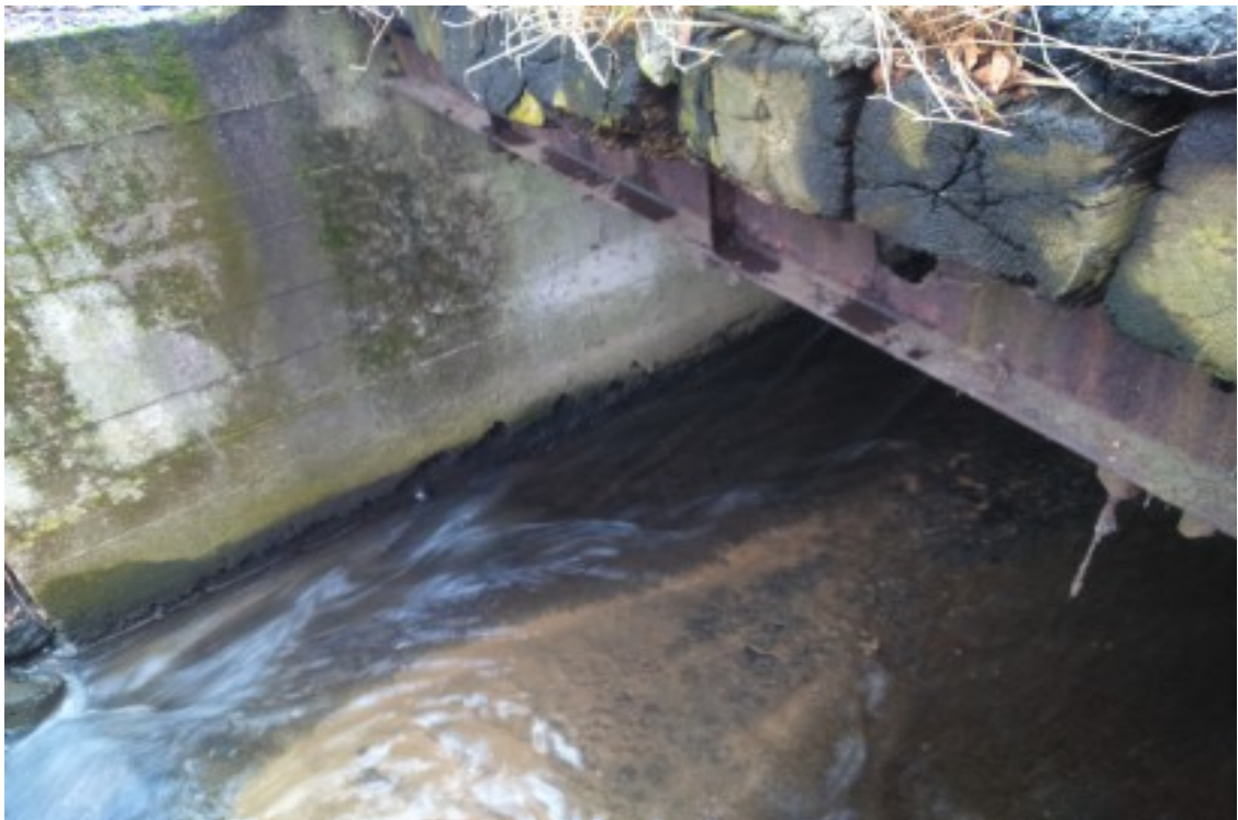
Zdjęcie nr 3.6 : Betonowy fragment przyczółka
