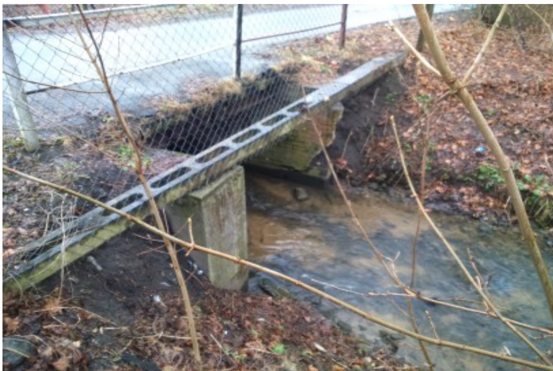
Zdjęcie nr 3.3: Widok mostu od strony zachodniej
