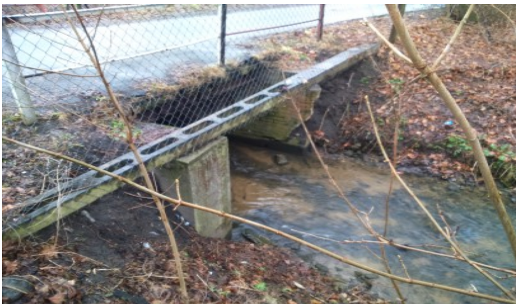
Widok ogólny obiektu mostowego
