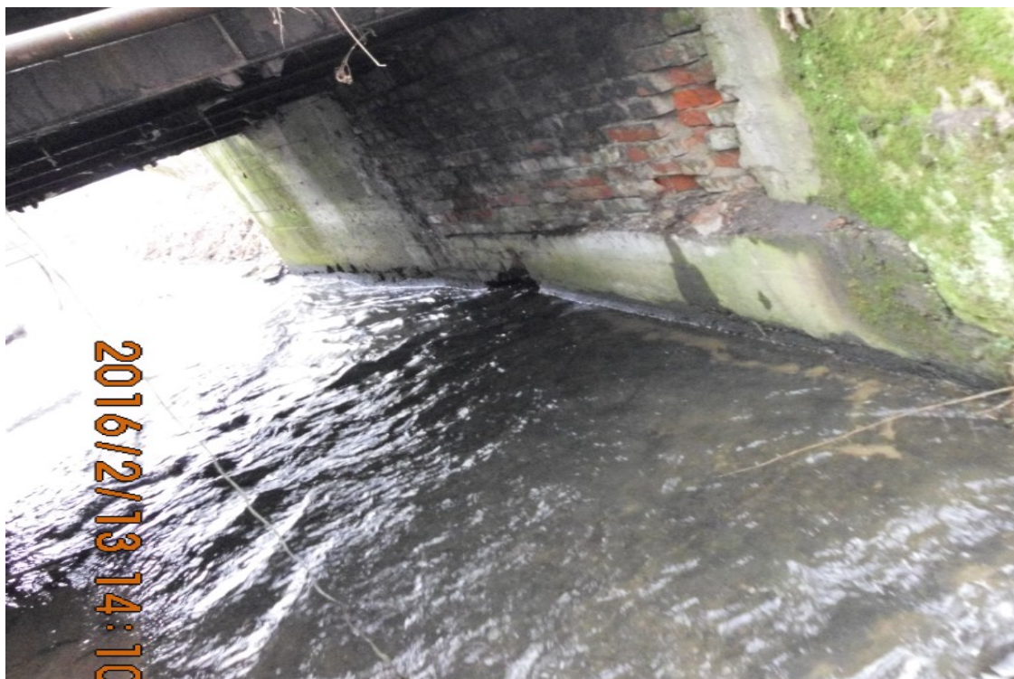
Zdjęcie 3.12 :Przestrzeń podmostowa
