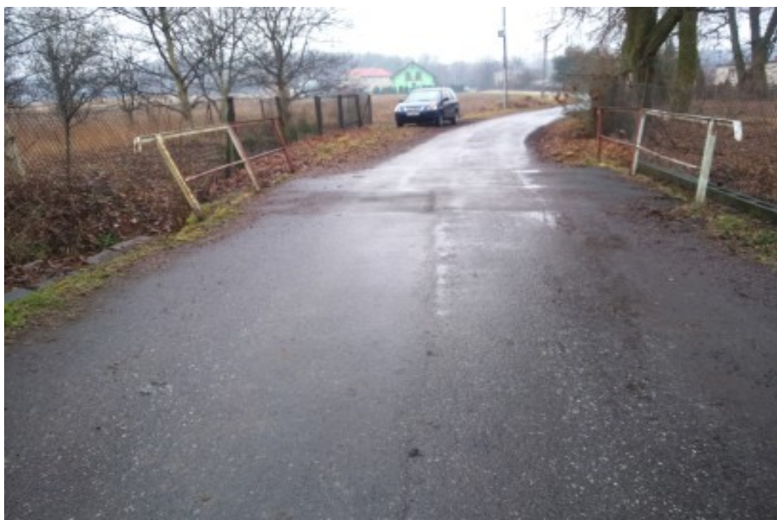
Zdjęcie nr 3.2 : Widok ogólny mostu od strony północnej
