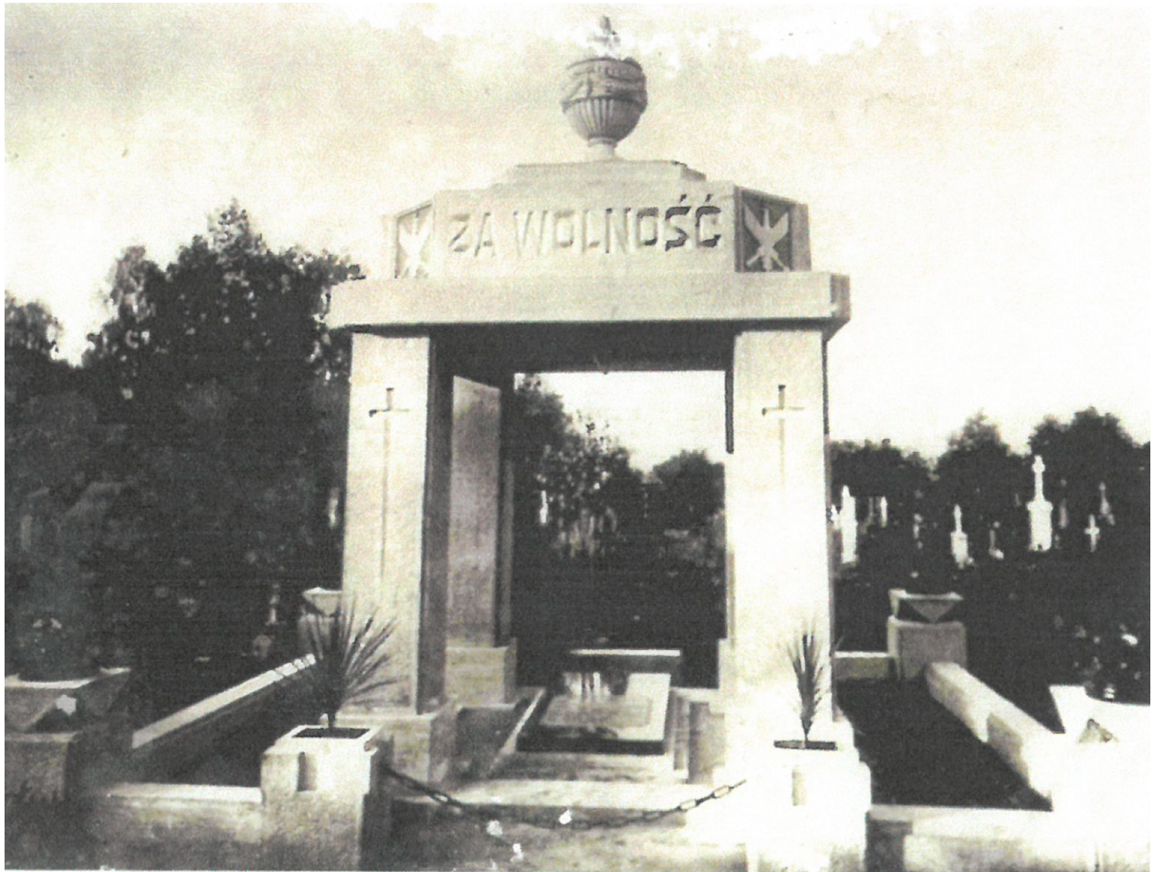
Fot. 1. Pomnik w roku 1930, po wybudowaniu
