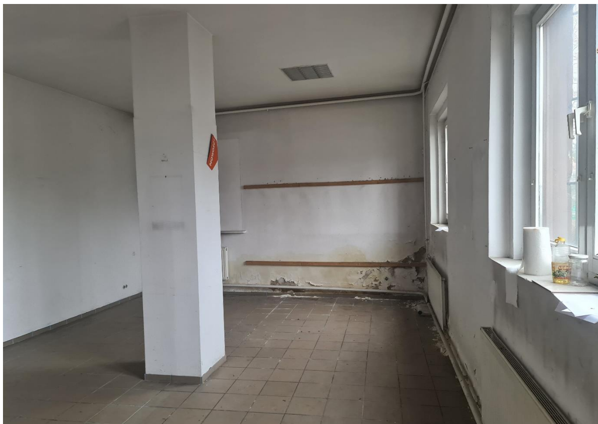
Zdjęcie 7 – widok wnętrza (parter- pomieszczenie od strony ulicy)
