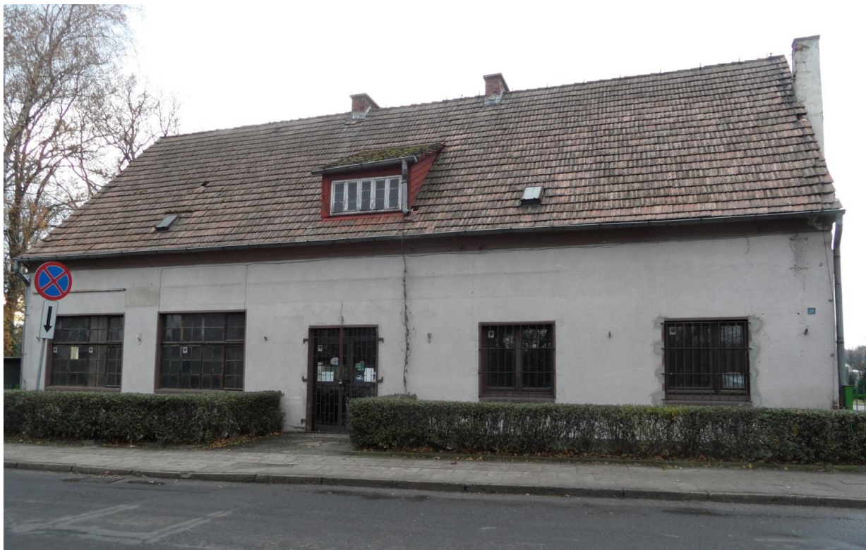
Zdjęcie 1 – widok od strony ulicy
