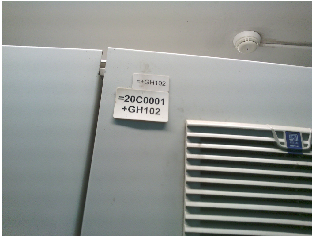
Pomiary kamerą termowizyjną - pomiary szafy GH102
