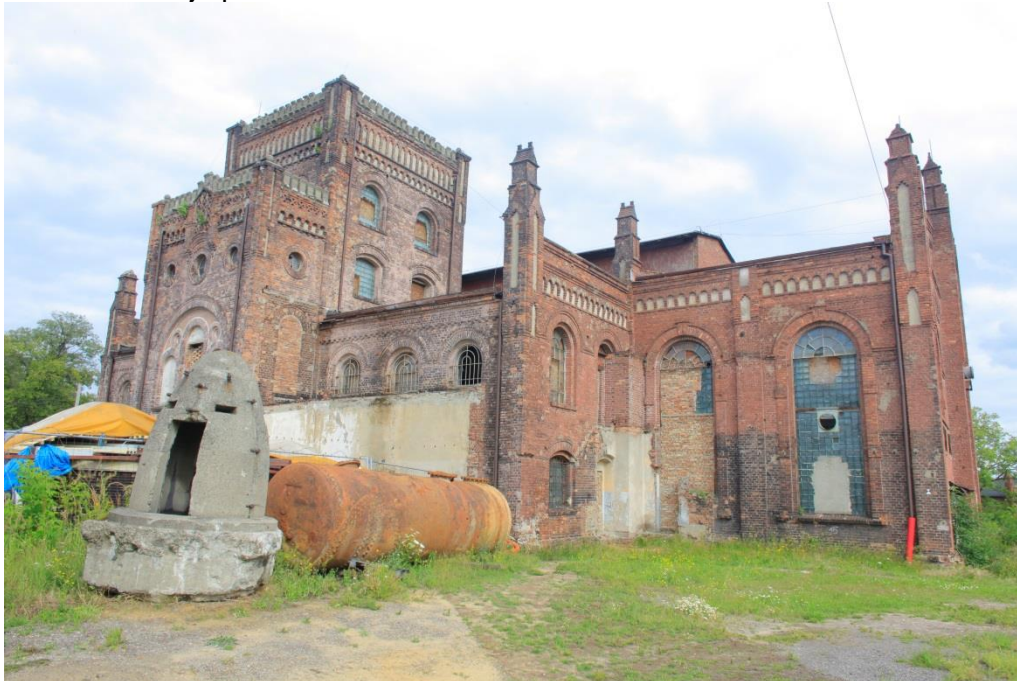
Fot. 2 Elewacja północno–zachodnia.
