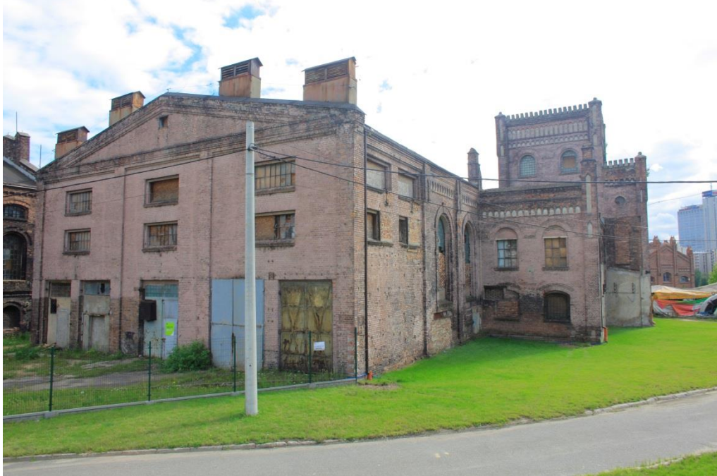
Fot. 1 Elewacja północno-wschodnia.
