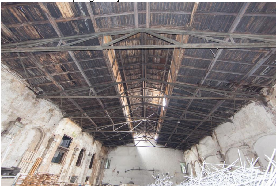
Fot. 3 Dach w części głównej obiektu.
