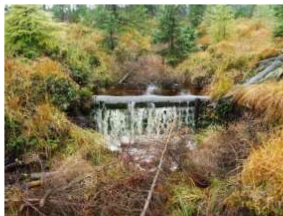
Próg drewniany na rowie odprowadzającym wodę z torfowisk po zboczu oraz rumosz drzewny wrzucany do rowu celem przyspieszenia zarastania – Nadleśnictwo Świeradów. Źródło: Archiwum CKPŚ
