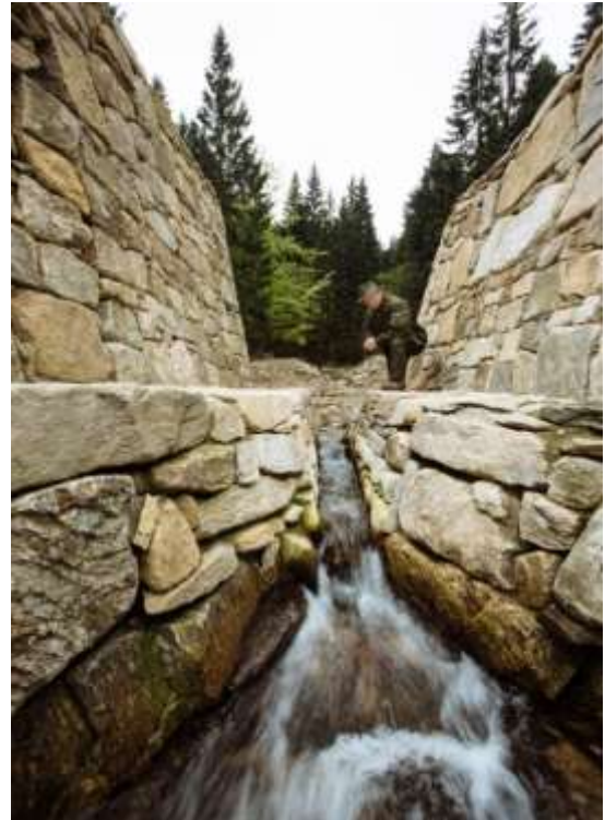
V-kształtny przelew wody ze zbiornika przeciwpowodziowego umożliwiający przejście rumowiska i samoczynne napełnianie i opróżnianie obiektu - Nadleśnictwo Międzyzlesie. Źródło: Archiwum CKPŚ. (rys. z prawej strony)
