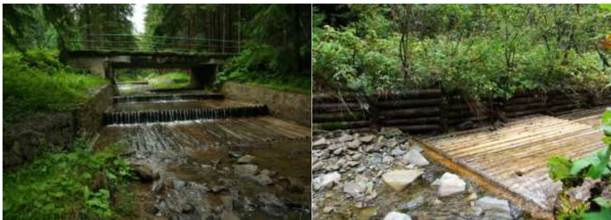
Stopnie wykonane z belek wzdłuż cieków przerywające ciągłość biologiczną. Źródło: Archiwum CKPŚ
