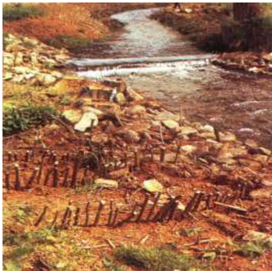
Płotek ze zrzesów wierzbowych tuż po wykonaniu (Begemann i Schiechtl 1999)
