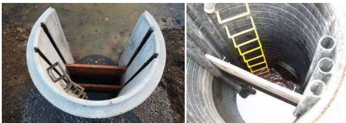
Studnia piętrząco-spustowa w trakcie budowy, widoczne kłamy zejściowe (fot. N-ctwo Lwówek Śląski i Szklarska Poręba)
