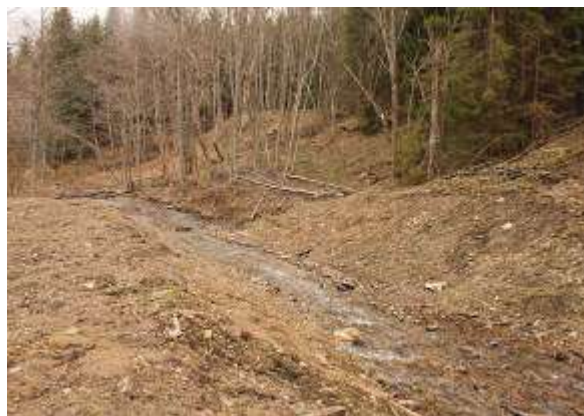
Miejsce po rozebraniu betonowego przepuście, w którym przywrócono ciągłość biologiczną cieku
