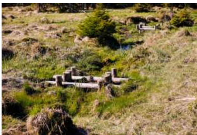
Zarastający rów odwadniający dzięki zastosowaniu przytamoń ziemno-drewnianych – Nadleśnictwo Szklarska Poręba. Źródło: Archiwum CKPŚ
