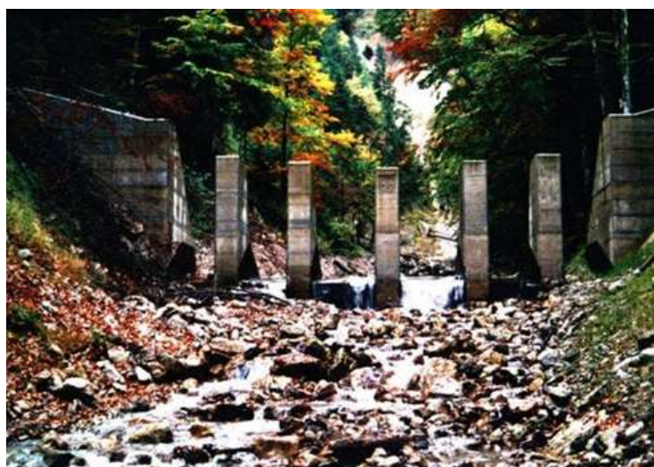
Zmodernizowana zapora szczelinowa (Austria)
