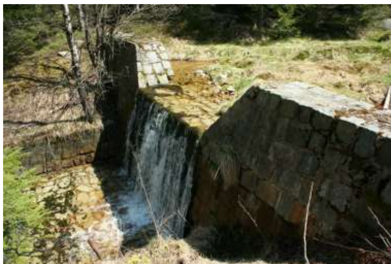
Wypełniona zapora tworzy wysoki próg – przerwana ciągłość cieku – Nadleśnictwo Szklarska Poręba. Źródło: Archiwum CKPŚ
