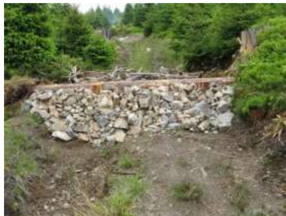
Przegrody drewniane wypełnione gałęziówką zabezpieczone narzutem kamiennym na szlakach zrywkowych (widok z góry i z dołu) (fot. N-ctwo Łądek Zdrój, RDLP Wrocław)
