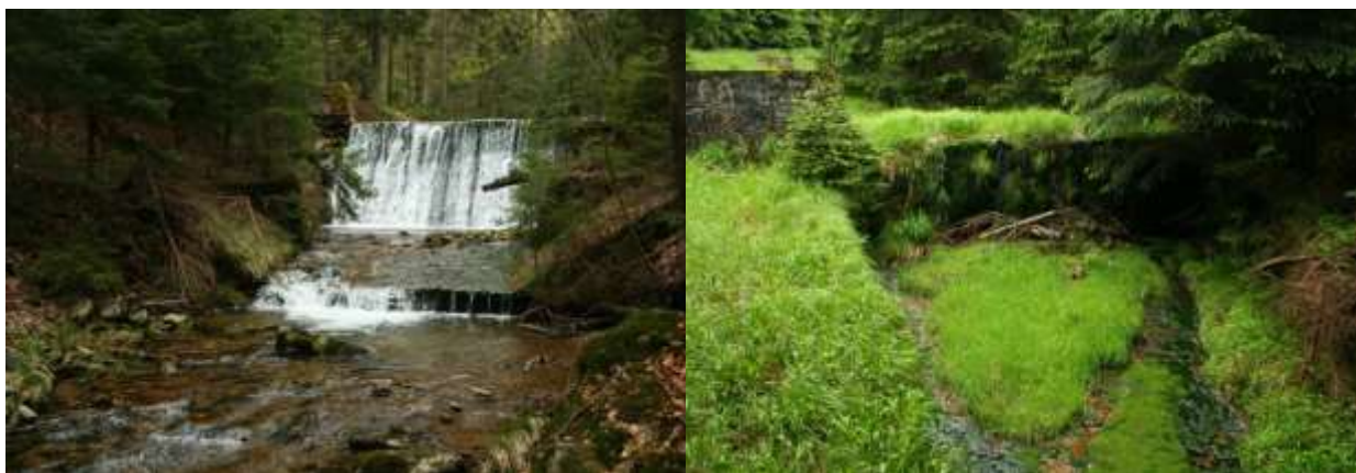
Całkowicie wypełniona zapora na cieku z potencjałem siedliskowym dla ryb – Nadleśnictwo Łądek Zdrój. Źródło: Archiwum CKPŚ.
