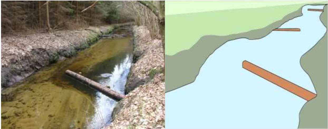
Najprostsze deflektory drewniane na wyprostowanym cieku wywołują pożądane zmiany w dnie i na przeciwległym brzegu
