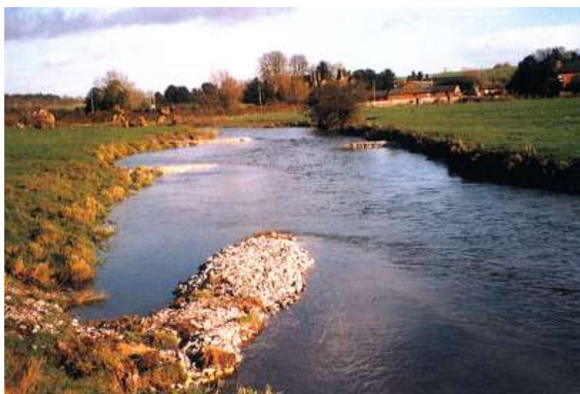
Fot. 4. Ochrona brzegów rzeki wyłącznie przez wykonanie głowic ostróg (Przyjazne naturze kształtowanie rzek i potoków 2006).
