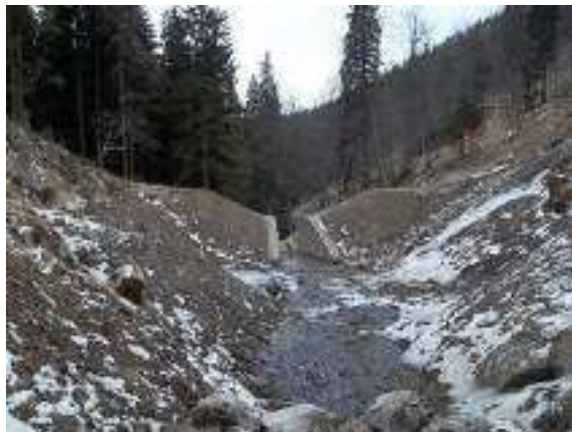
Suchy zbiornik w I-ctwie Jawornica z przelewem szczelinowym (przeławką) (fot. N-ctwo Międzyzlesie)
