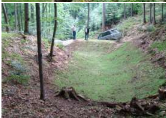
Wspaniałe przykłady wykorzystania naturalnego ukształtowania terenu, które po drobnych modyfikacjach stanowi idealne miejsce na zbiornik retencyjny – Nadleśnictwo Piwniczna. Źródło: Archiwum CKPŚ
