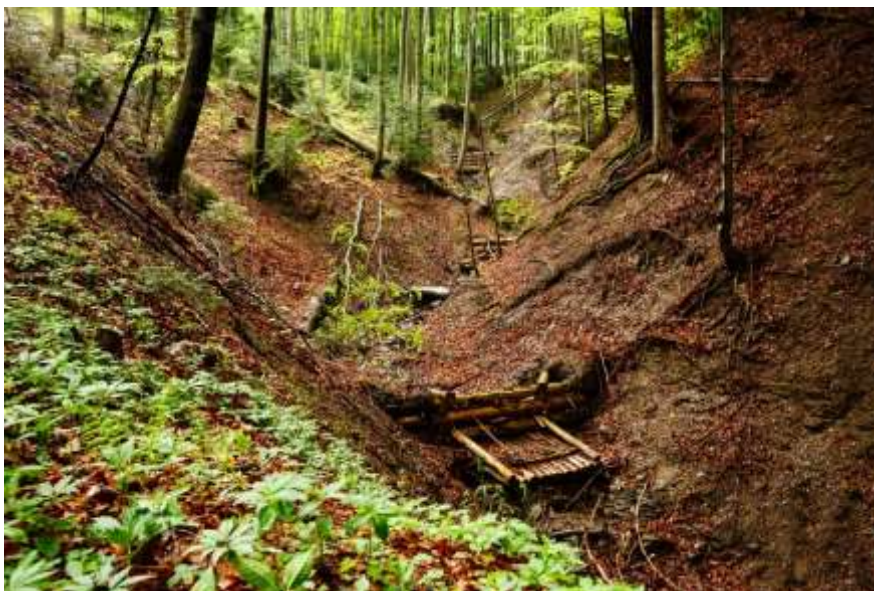
Niewielkie zapory przeciwrumowiskowe seryjnie rozłożone w wyerodowanym wąwozie na cieku okresowym. Źródło: Archiwum CKPŚ
