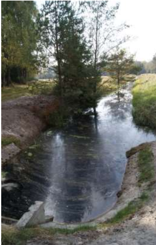
Zbiorniki na poszerzonym rowie w N-ctwie Walcz
