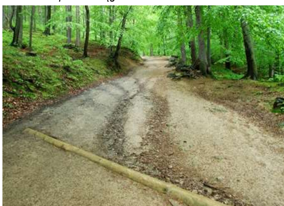
Wodospust z pojedynczego okrągłaka
