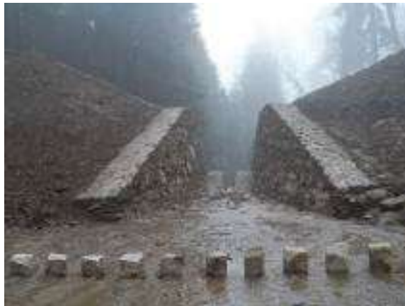
Suchy zbiornik w I-ctwie Jawornica z przelewem szczelinowym (przeławką) (fot. N-ctwo Międzyzlesie)
