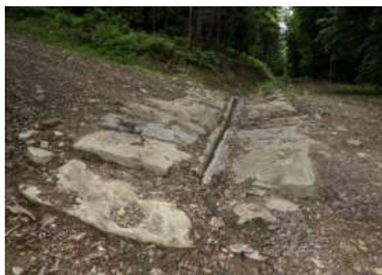
Wodospust odprowadzający wodę z drogi do lasu.
