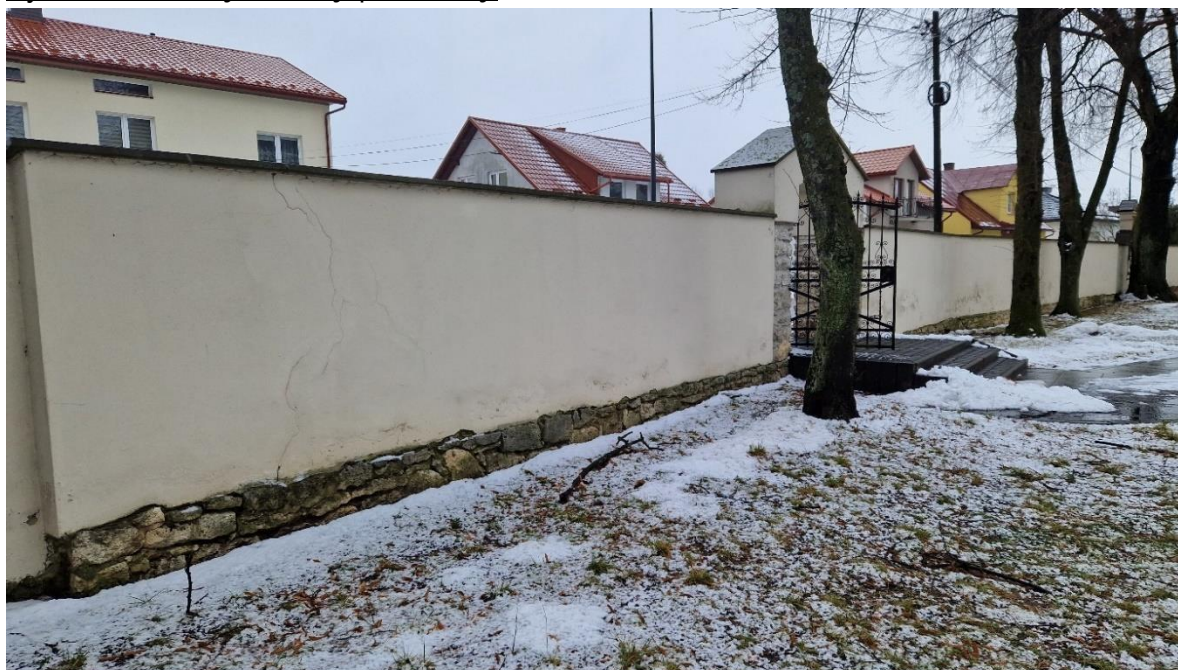
Fot. Sposób odizolowania tynku od gruntu na elewacji północnej. Stan zachowania na 2024 r.
