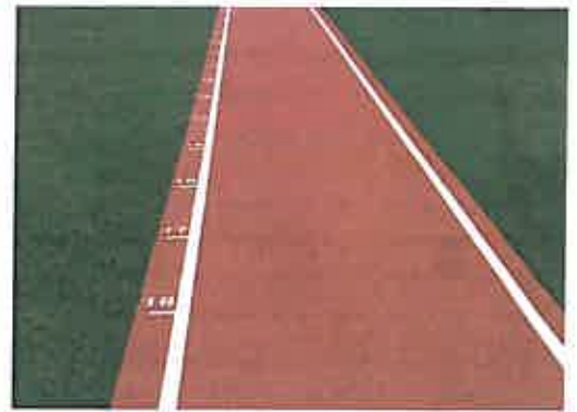
fot. 3 Oznaczenia odległości na rozbiegu przy małym marginesie nawierzchni
