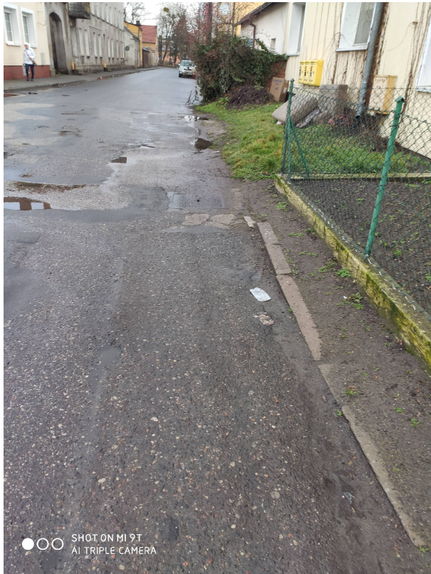
Zdjęcie nr 2: Istniejąca droga dojazdowa o licznych ubytkach i zastoiskach wody
