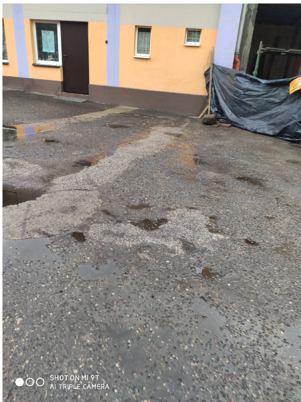
Zdjęcie nr 3: Istniejąca droga manewrowa o licznych nierównościach i zastoiskach wody
