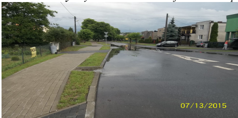
Zastoiska wody- wykonanie ścieku lub frezowanie i powtórne profilowanie
