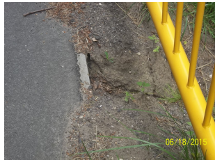
Przepusty - luźne kamienie zabruku do ponownego montażu
