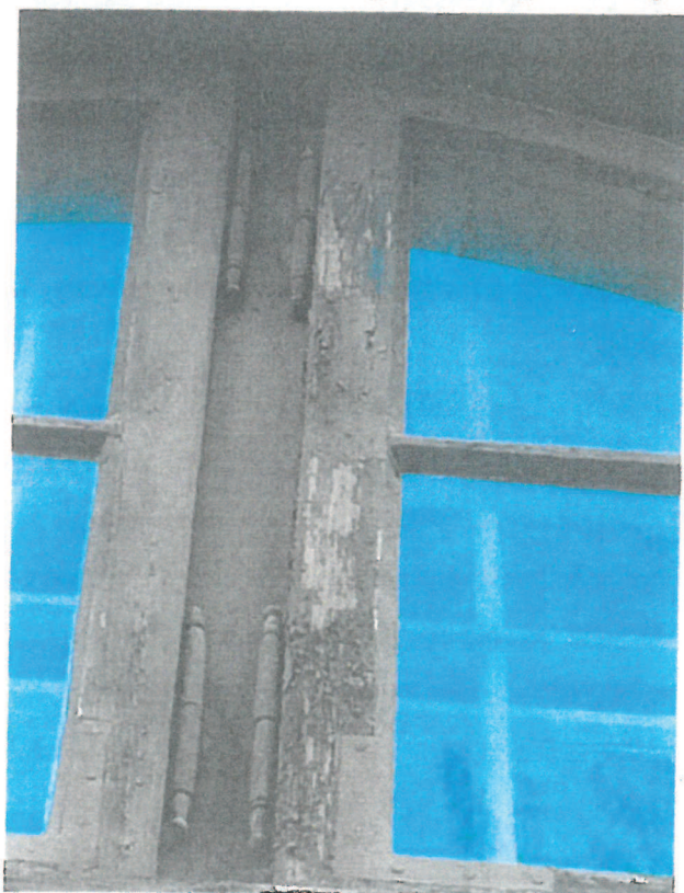
Fot. nr 63. Odkrywka na oknach na elewacji. Najstarsza zachowana warstwa malarska jest w kolorze brązowym.
