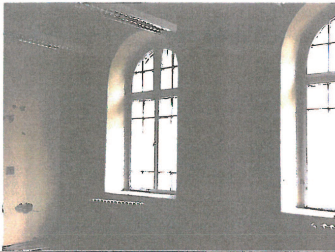
Fot. nr 12. Pomieszczenie nr 2 usytuowane od strony pn-wsch. budynku.
