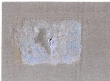
Fot. nr 24. Odkrywka nr 1 w pomieszczeniu nr 4
