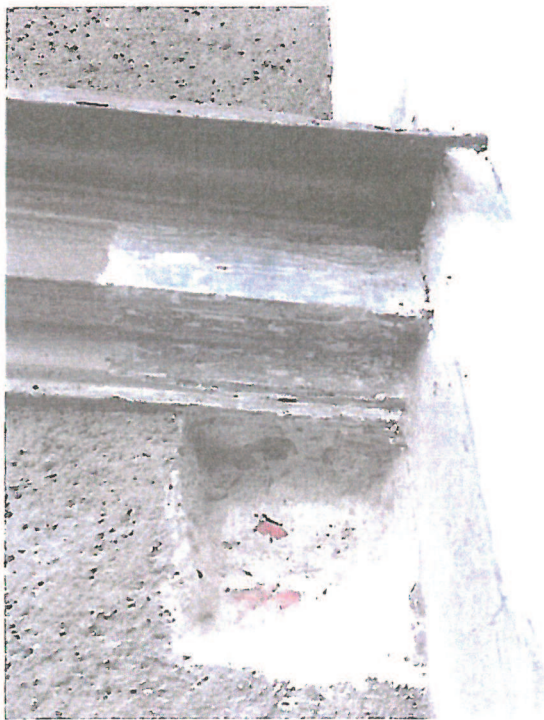
Fot. nr 61. Odkrywka na elewacji wschodniej. Widoczny szary kolor na profilowanych opaskach.
