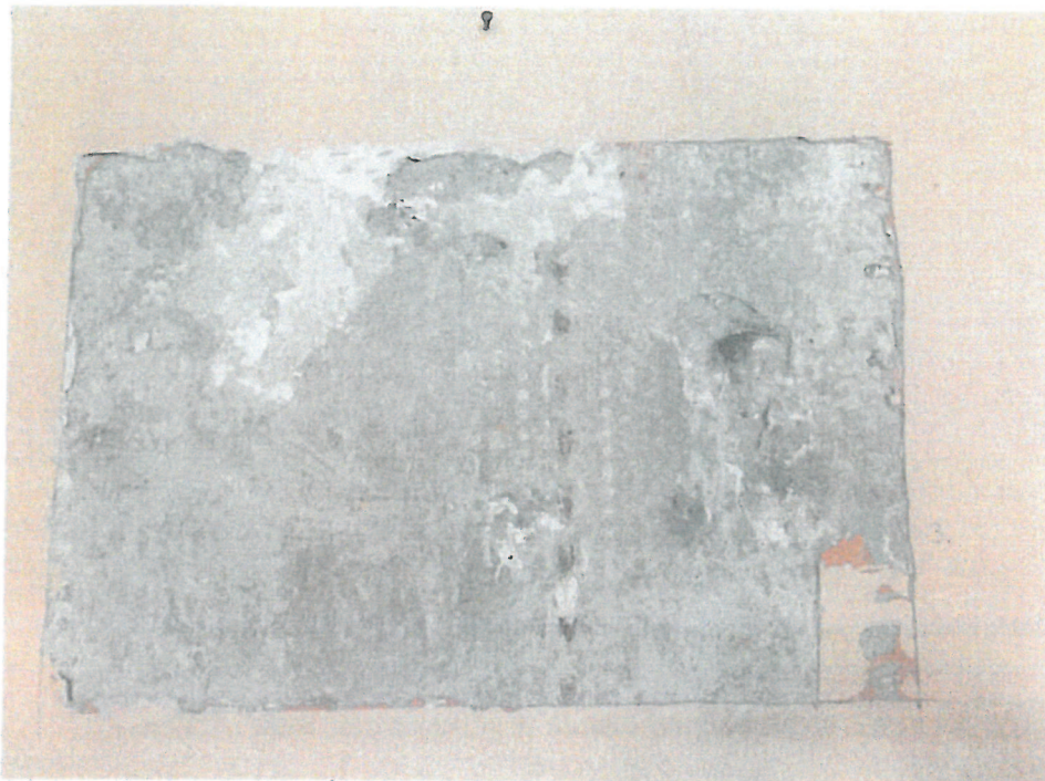
Fot. nr 20. Odkrywka nr 3 w pomieszczeniu nr 3 na ścianie wschodniej, odślonięta polichromia.
