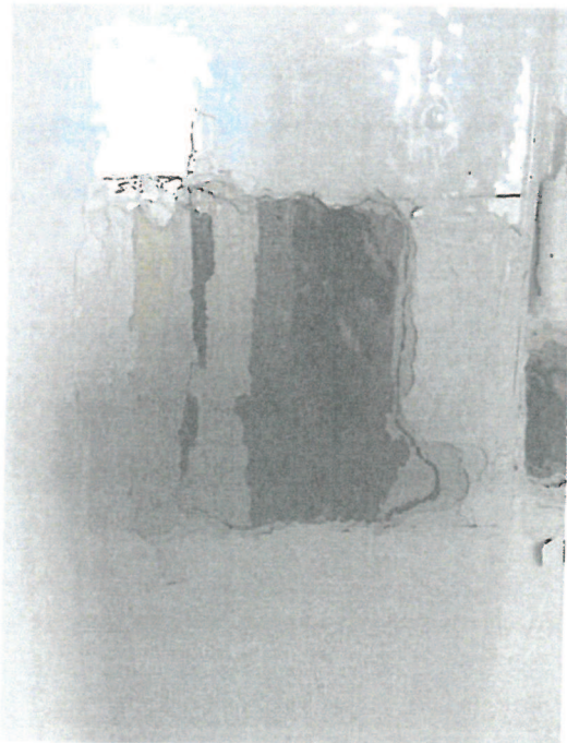
Fot. nr 57. Odkrywka stratygraficzna na drzwiach w sali widowiskowej.
