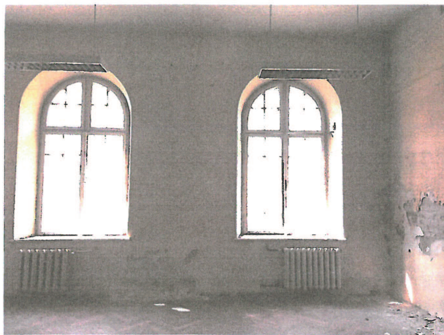
Fot. nr 19. pomieszczenie nr 3. Ściana zachodnia.
