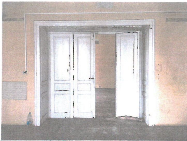
Fot. nr 23. Pomieszczenie nr 4. Widok na północną ścianę z czteroskrzydłowymi drzwiami.
