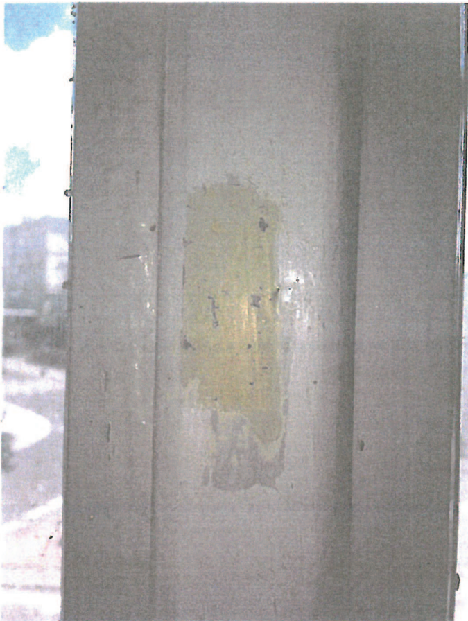
Fot. nr 58. Odkrywka na stolarcze okiennej w sali widowiskowej.
