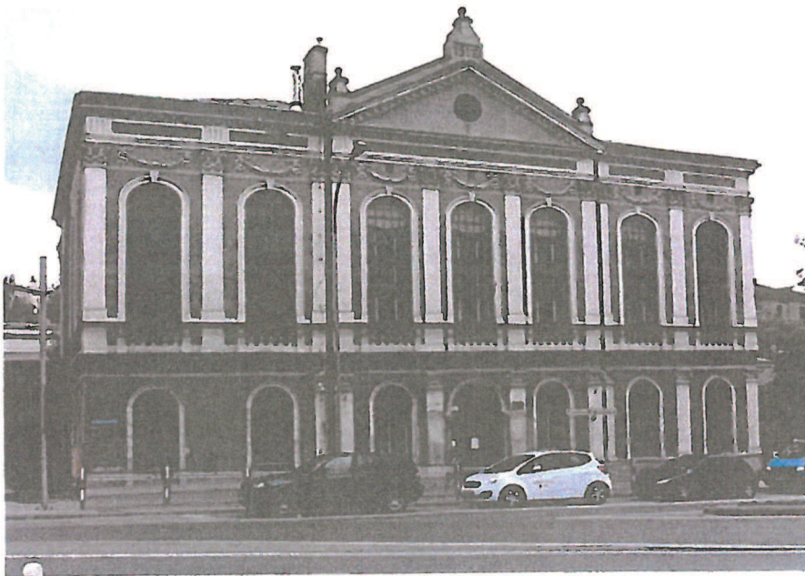
Fot. nr 1. d. Budynek Towarzystwa Żydowskiego „Jad Charyjcem“. Elewacja frontowa.
