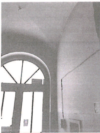
Fot. nr 30. Pierwsza część sieni. Widoczne wtórne drzwi wejściowe.
