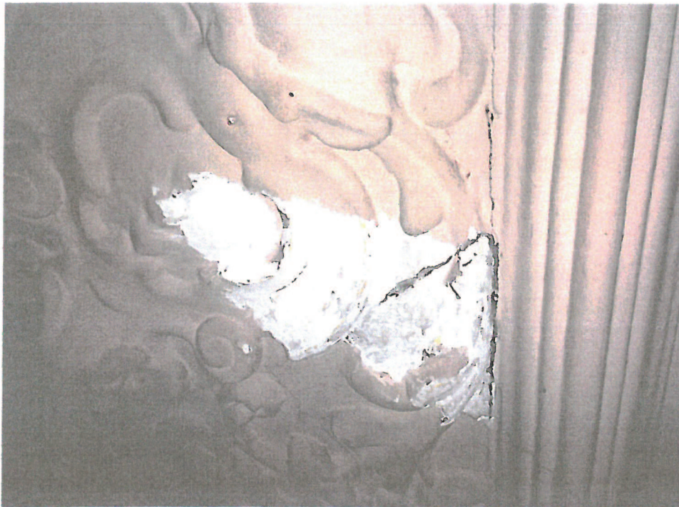
Fot. nr 54. Odkrywka na sztukateriach na suficie w sali widowiskowej. Widoczny jasnokremowa pobiąta wapienna i jasnoszary kolor.
