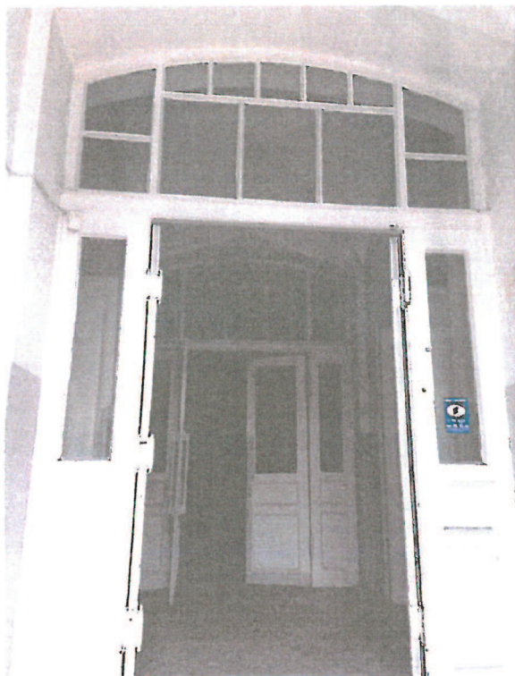
Fot. nr 29. Sień. Drzwi wahadłowe z doświetleniem.
