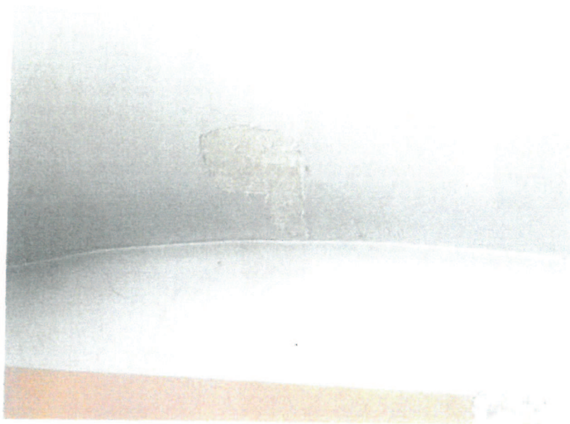
Fot. nr 42. Odkrywka na suficie.
