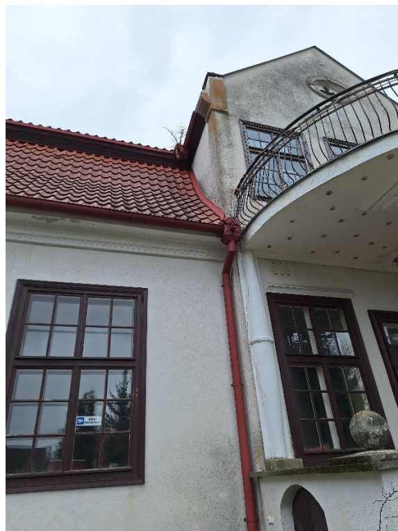
Zakres – czyszczenie rynien, regulacja spadków rynien, regulacja rur spustowych – ust. 1 pkt 13) lit a) OPZ
