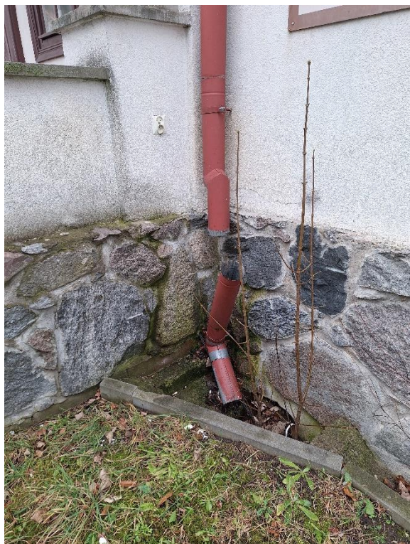
Zakres – czyszczenie rynien, regulacja spadków rynien, regulacja rur spustowych – ust. 1 pkt 13) lit a) OPZ
