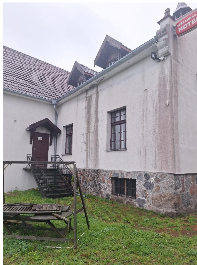
Zakres wymiany i uszczelnienia obróbki blacharskiej okapu – od strony zachodniej budynku oficyny – ust. 1 pkt 13) lit b) OPZ
