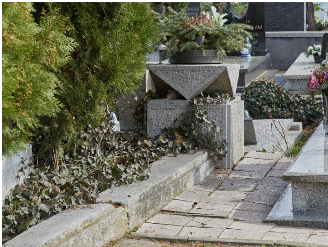
Fot. 34. Fragment ogrodzenia z pęknięciem
