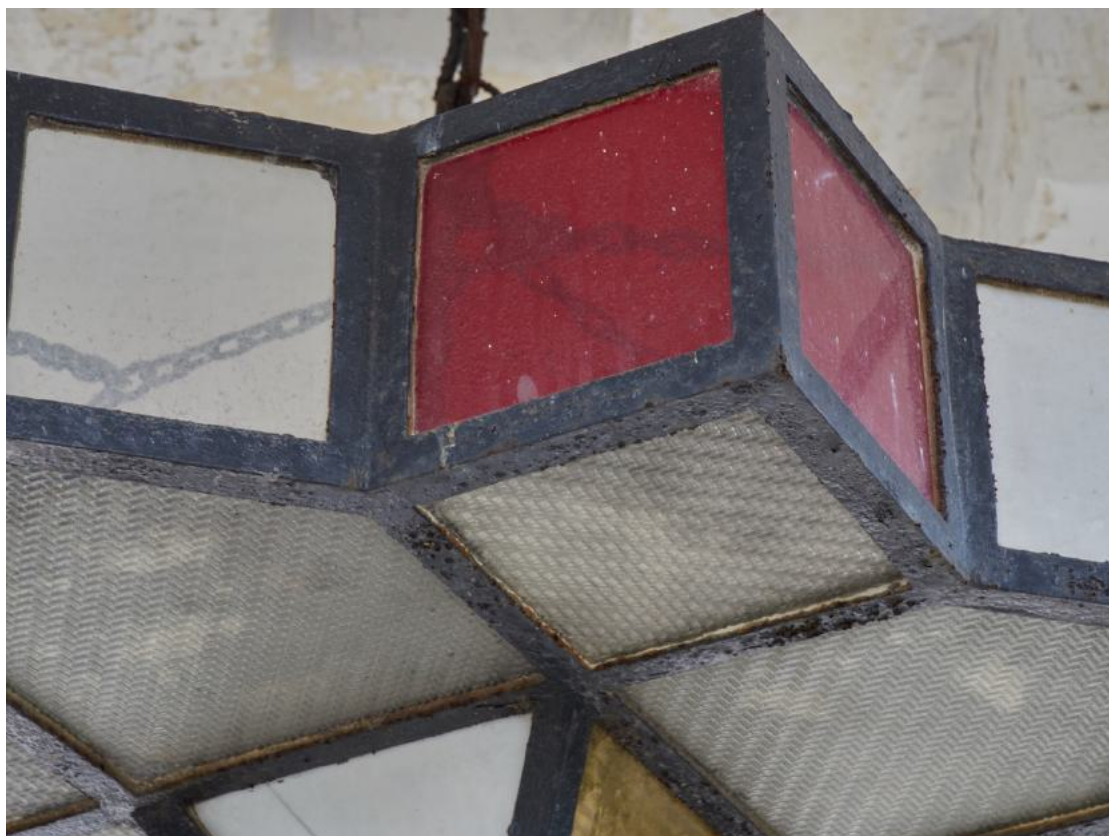
Fot. 22. Żyrandol – detal. Widoczne ogniska korozyjne na metalu
