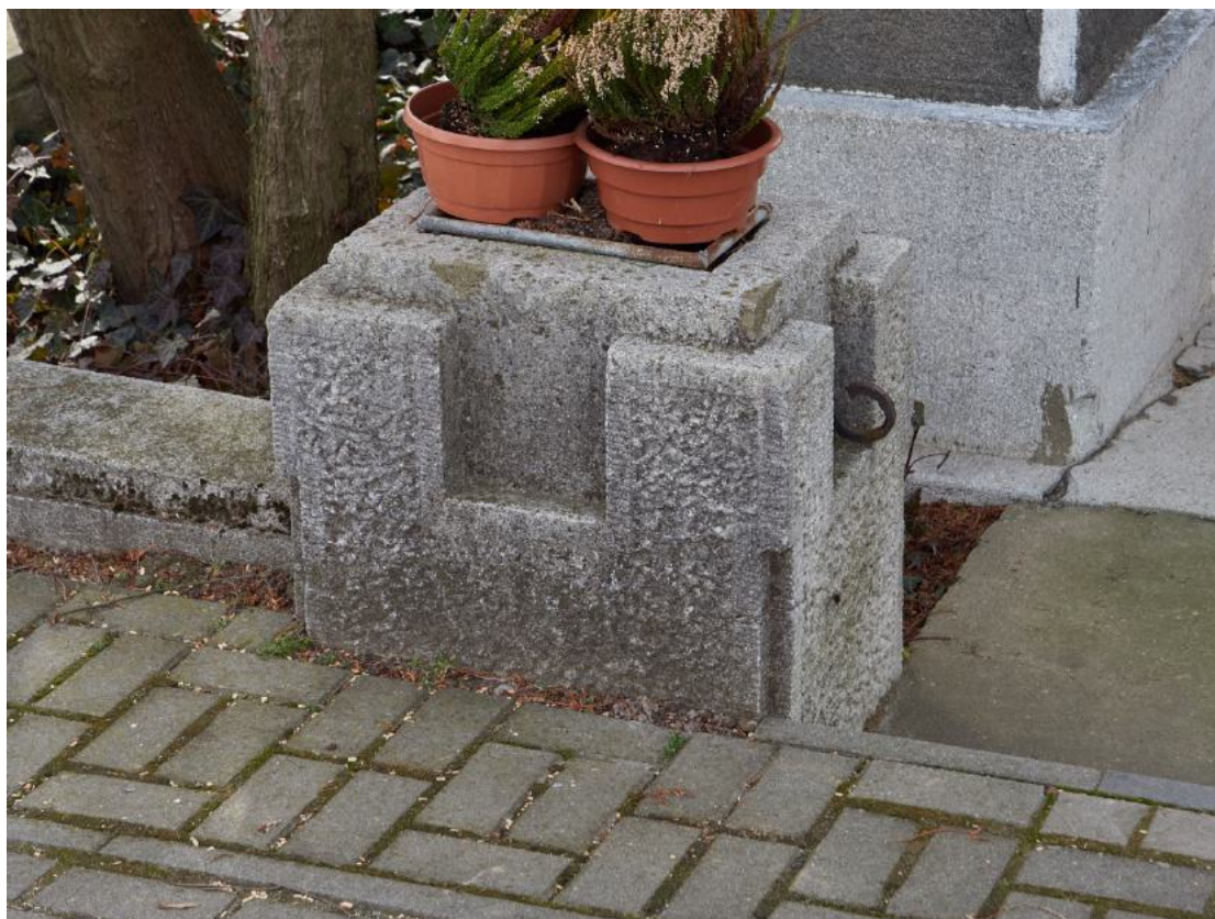
Fot. 30. Element ogrodzenia – widoczny hak do montażu łańcucha
