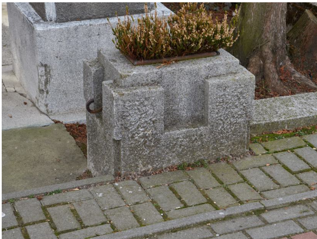
Fot. 31. Element ogrodzenia – widoczny hak do montażu łańcucha
