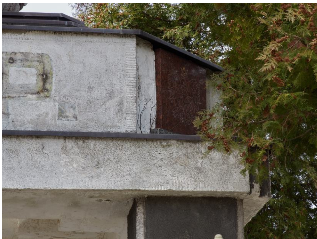
Fot. 19. Wtórna płyta kamienna z orłem na zwieńczeniu – element przeznaczony do usunięcia
