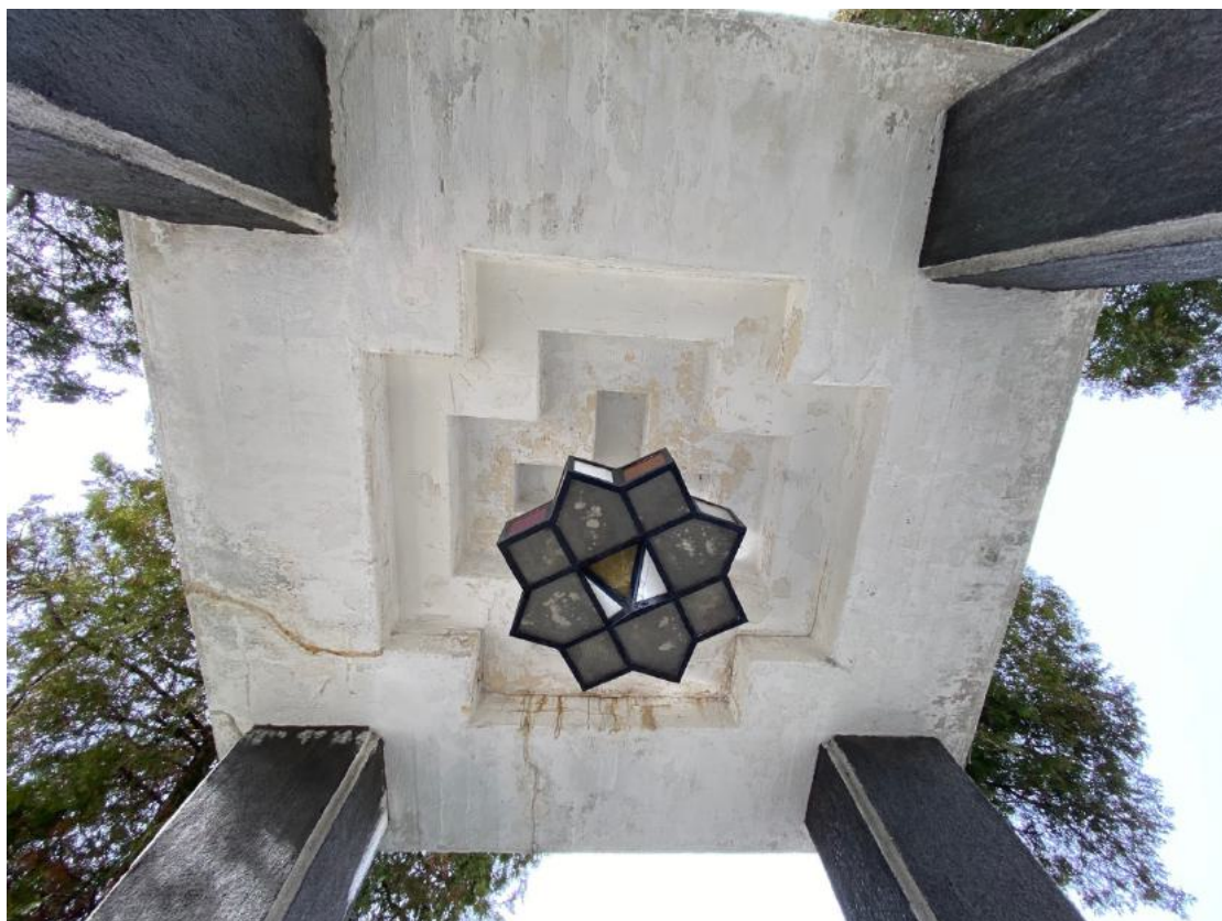
Fot. 7. Sklepienie widziane od dołu. W centrum metalowo-szklany żyrandol
