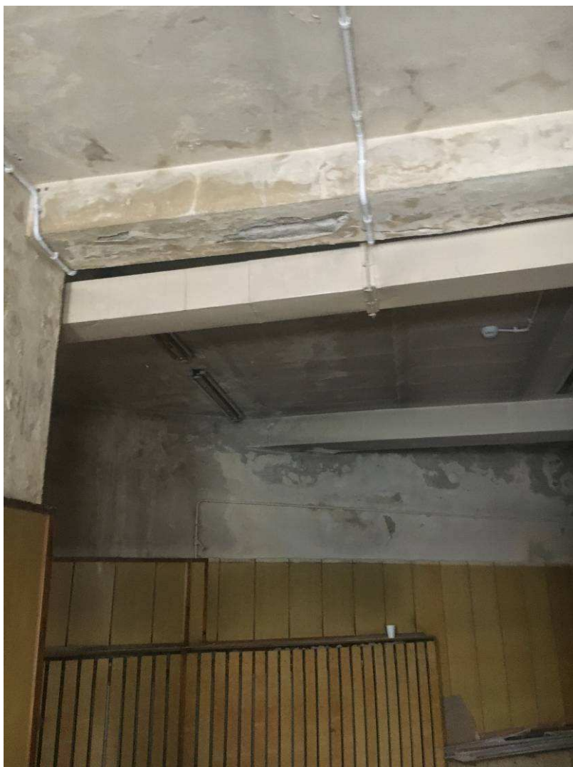
Fot. 8. Budynek 120 – zawilgocenia stropodachu.
