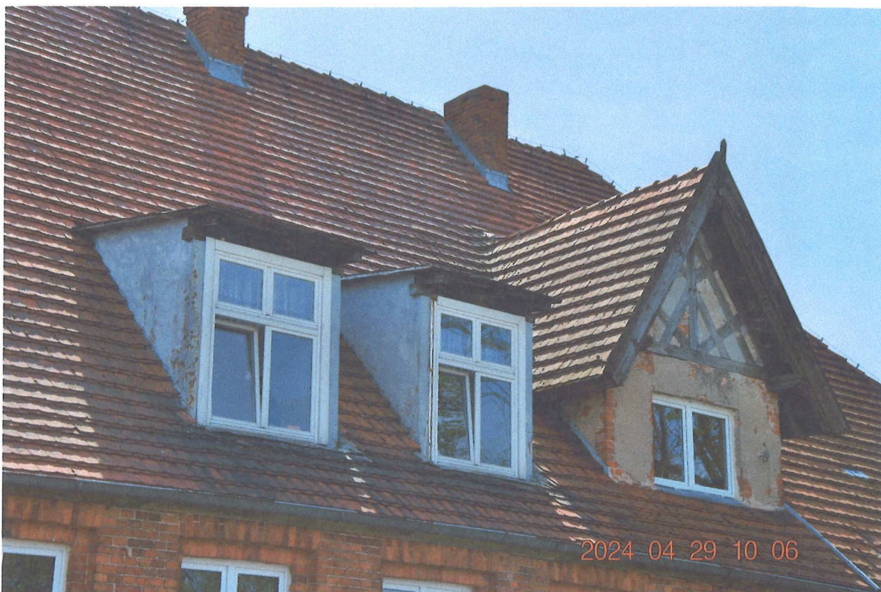
fot.3 Widok na lukarny dachowe
