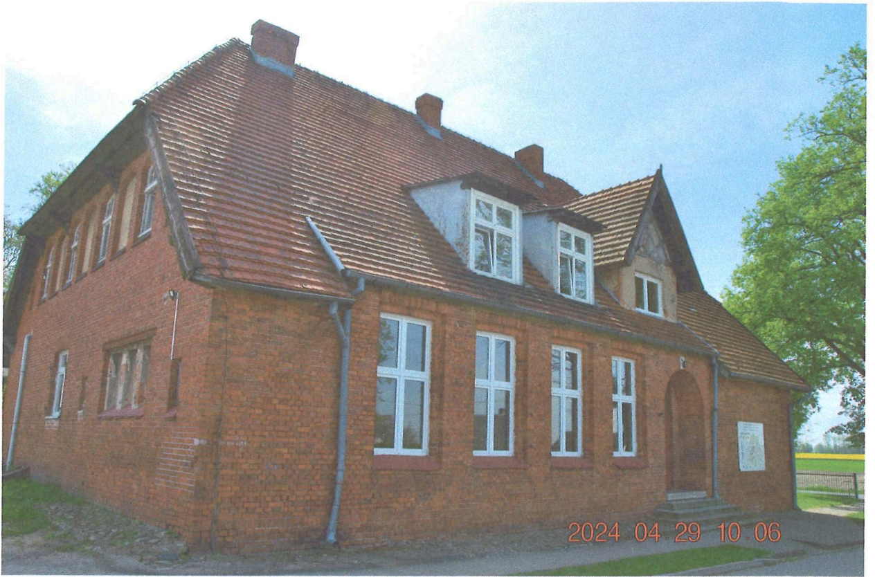
fot.1 Widok połaci zachodniej
