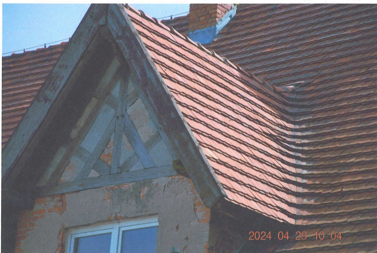
fot.4 Lukarna z szachulcem oraz tzw. miękki kosz dachowy kryty dachówką
