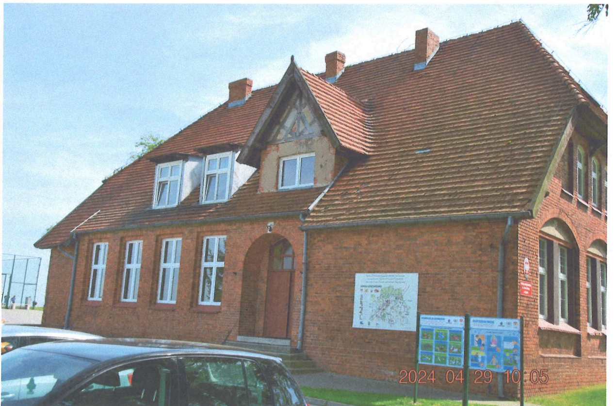
fot.2 Widok połaci zachodniej
