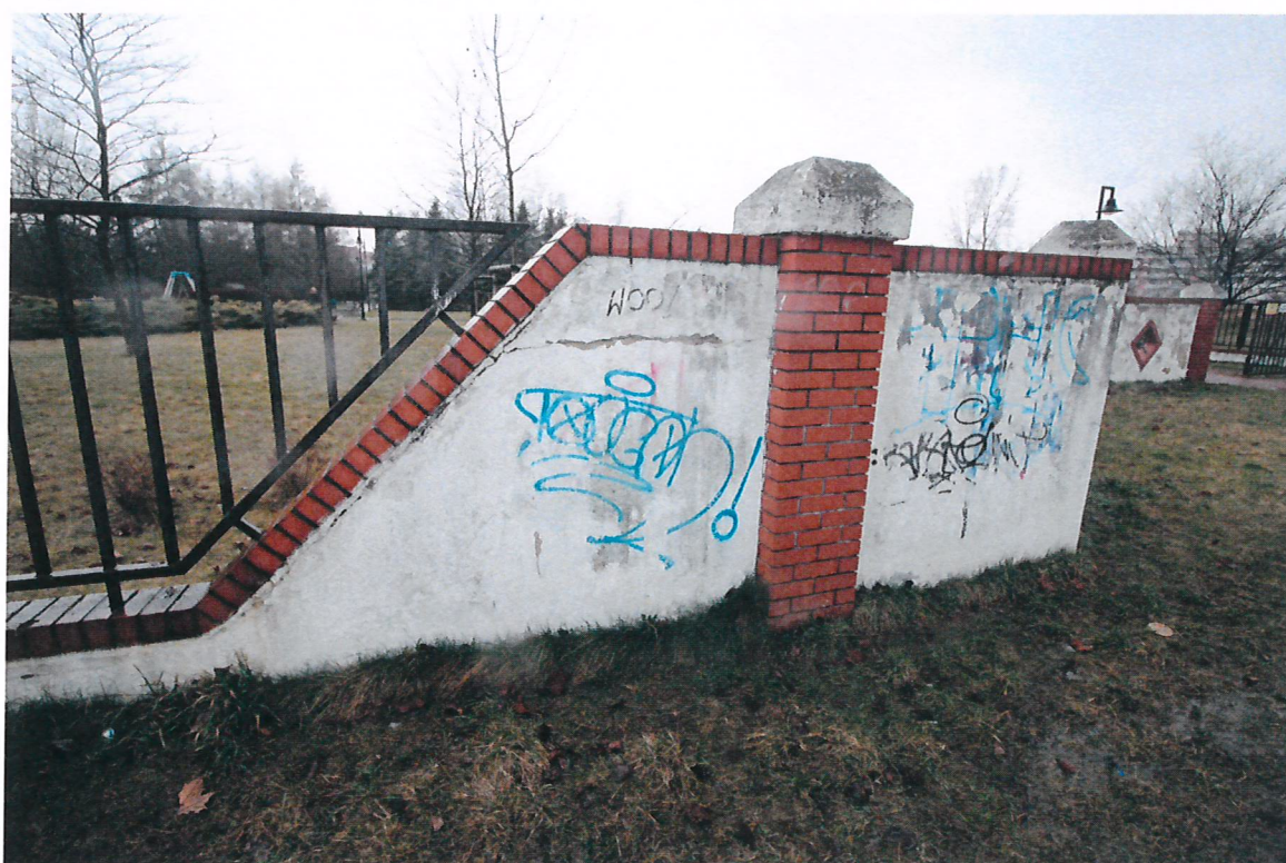
zaawansowana korozja przęsla stalowego
