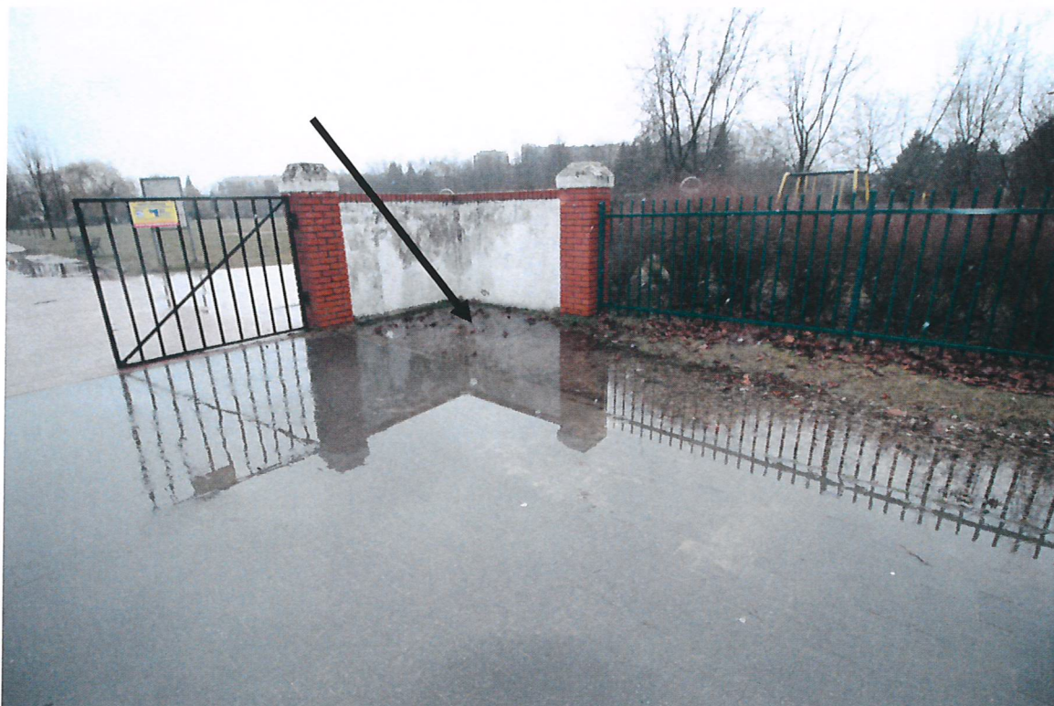
nieprawidłowy spadek nawierzchni-zastoiny wody przy ogrodzeniu
