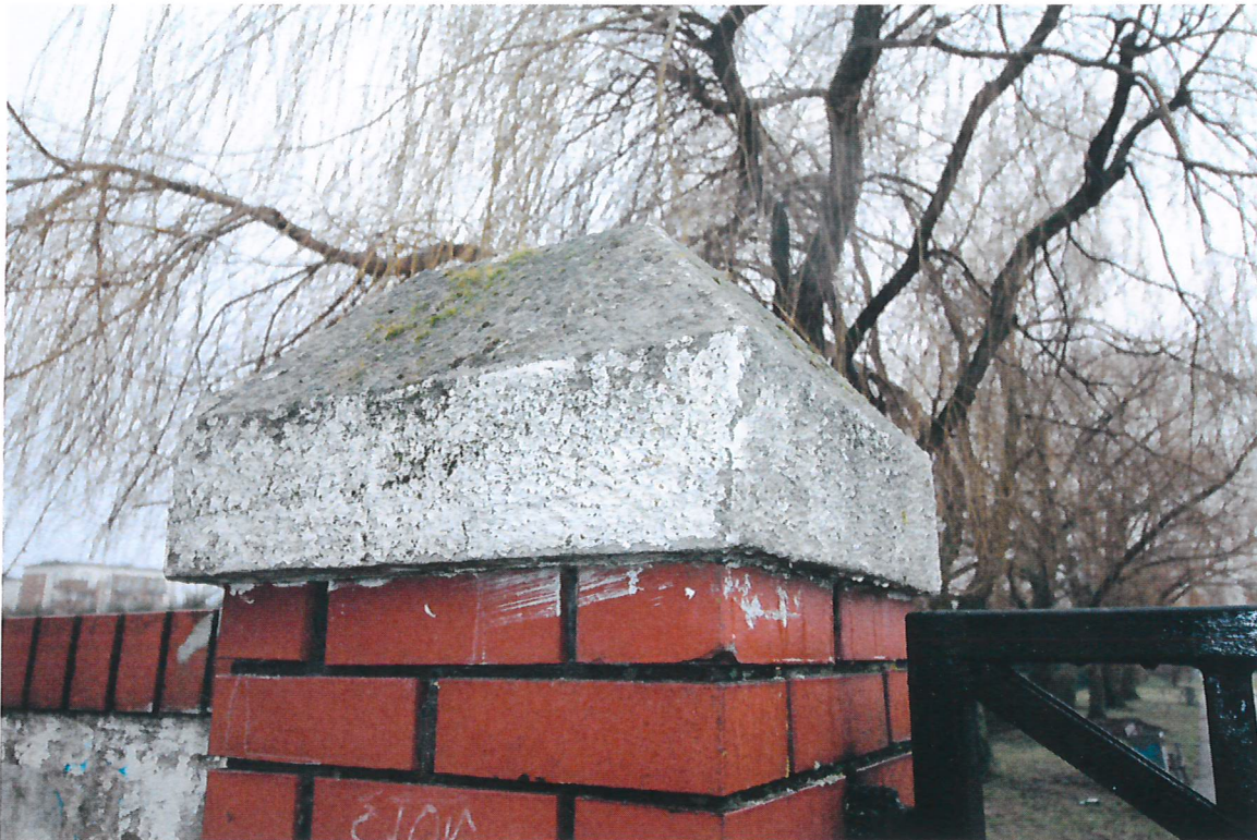
nieprawidłowy spadek nawierzchni-zastoiny wody przy ogrodzeniu
