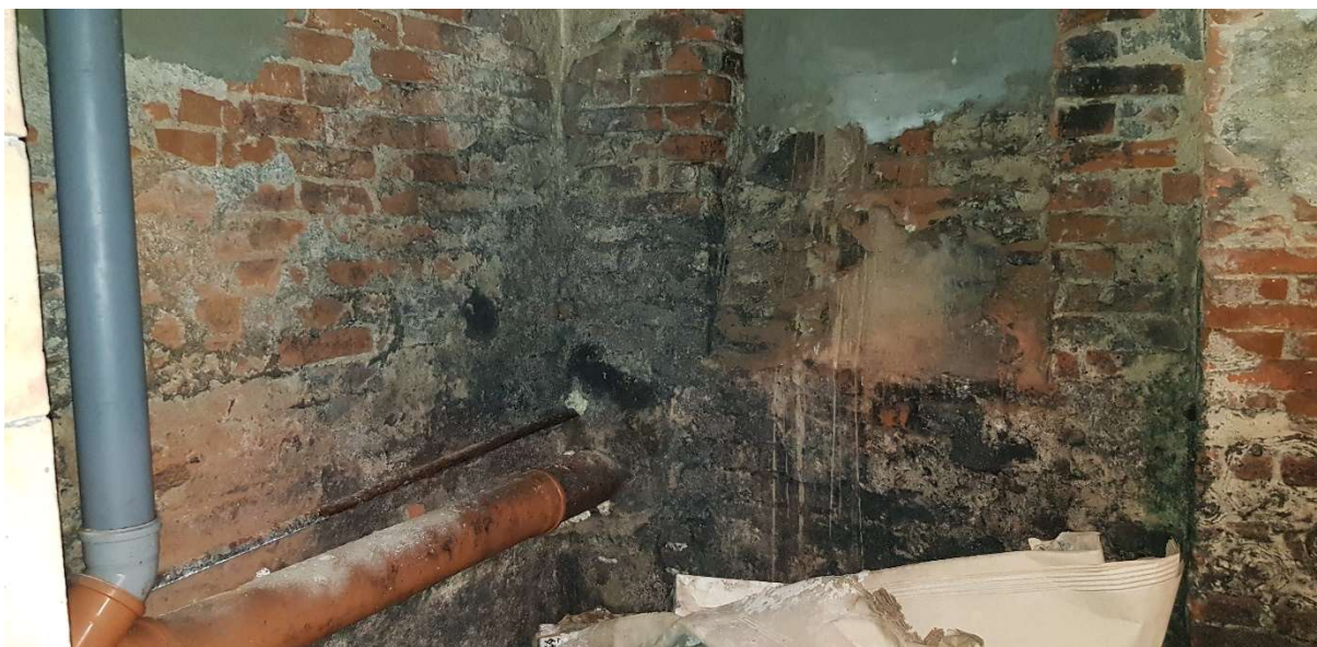
Stare otwory okienne zamurowane. Brak wentylacji.
