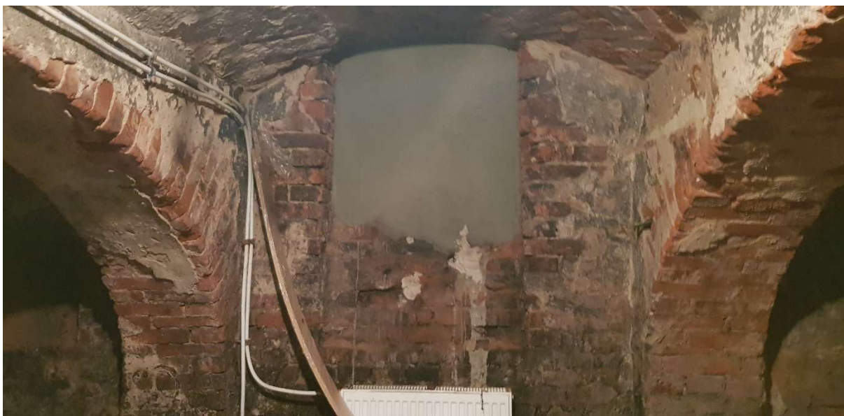
Jedno z pomieszczeń wypełnione odpadami. Stolarka drzwiowa tego pomieszczenia w stanie rozkładu.
