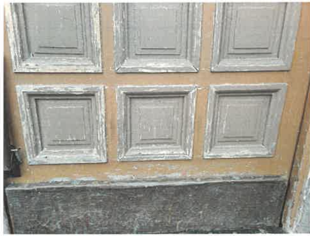
2. Widok ubytków w zewnętrznej stronie drzwi wejściowych.
