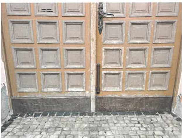
2. Widok ubytków w zewnętrznej stronie drzwi wejściowych.
