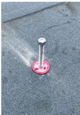
Rys. 13. Zamontowana kotew z elementem uszczelniającym
