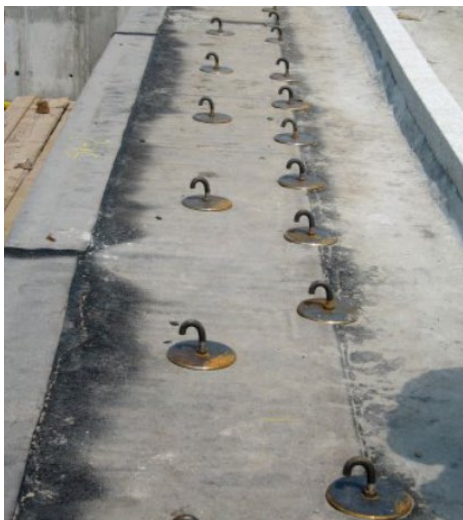
Rys. 9. Dolna część kotwy zabetonowana w ustroju, z dokręconą górną częścią.
