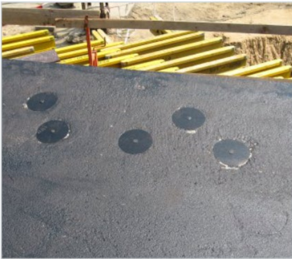
Rys. 8. Zlicowanie dolnego talerza kotwy z powierzchnią betonu ustroju nosącego
