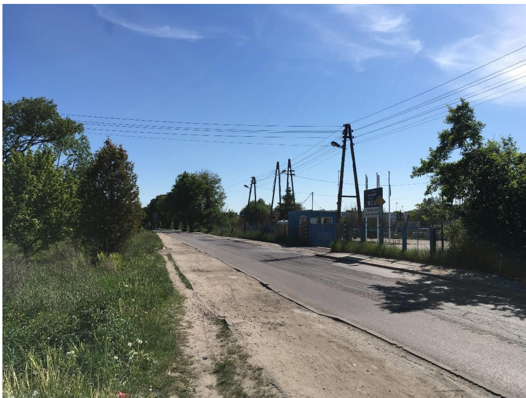
23enn: Linia napowietrzna nn-0,4kV (obwód 1882-2/500) z obwodem oświetleniowym
