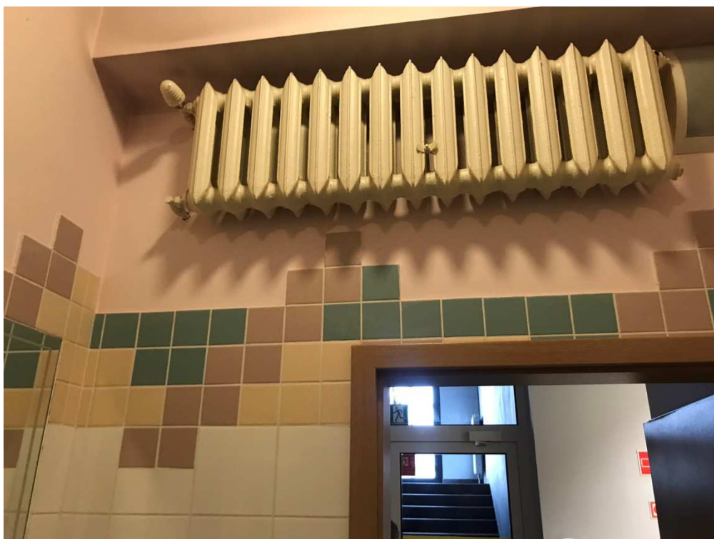
Dok. fot. nr 1 – grzejniki wymagają czyszczenia, malowania
