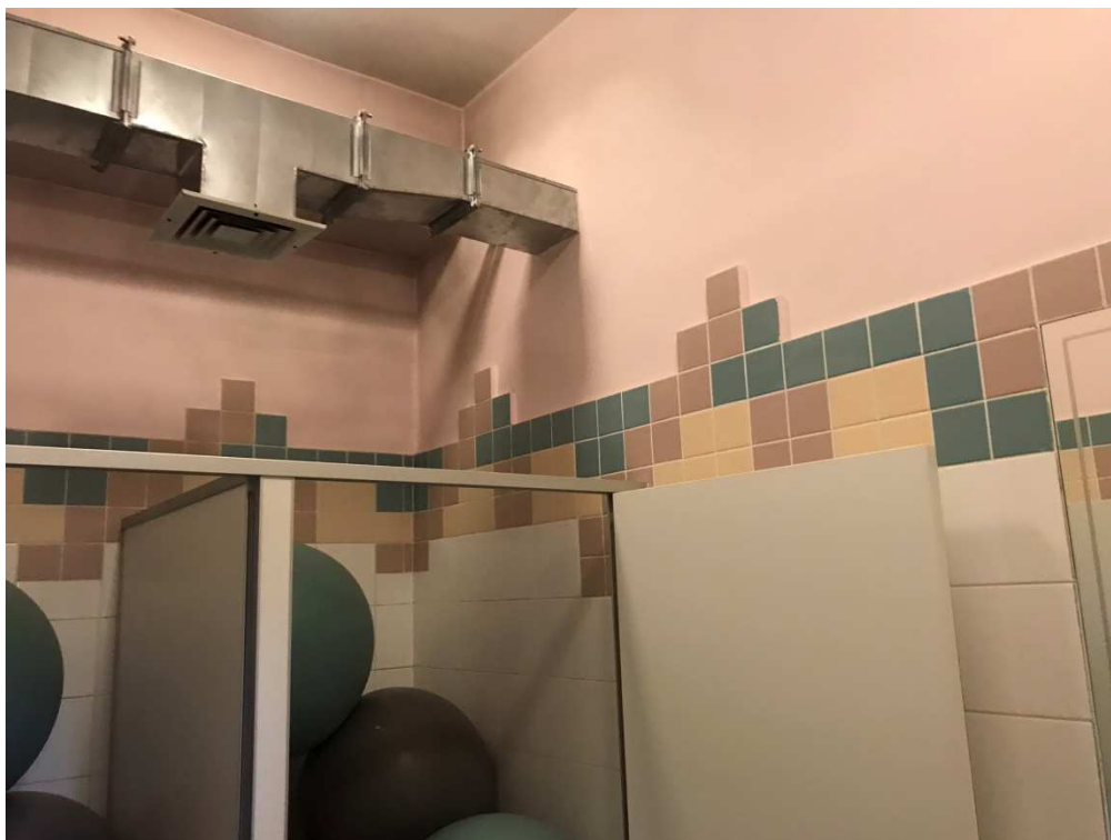
Dok. fot. nr 3 – lekkie przegrody w proj szatni przy fizykoterapii do demontażu, dekoracyjne kolorowe płytki poniżej 2m należy zostawić, a aranżacje (stare + nowe) będą rozwiązywane na bieżąco z inwestorem.
