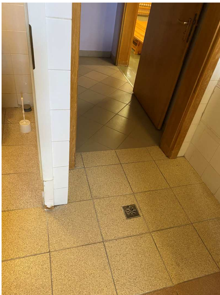
Dok. fot. nr 9 – Granica położenia nowej posadzki w drzwiach, na linii płytek korytarza.
