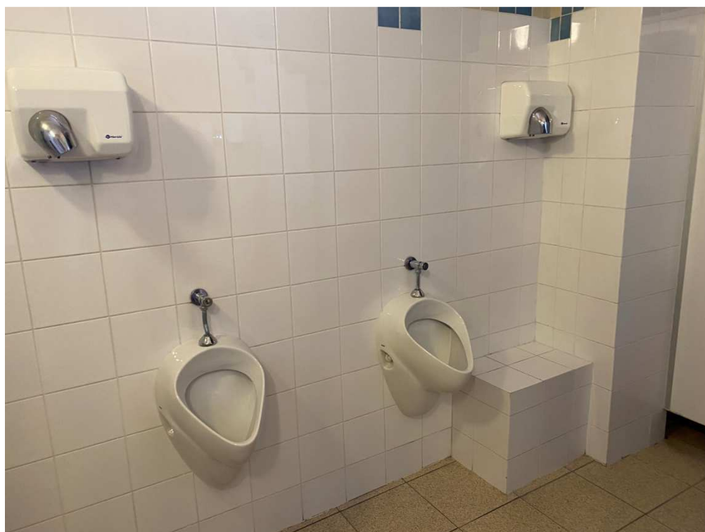
Dok. fot. nr 6 – posadzka i płytki ściennie do poziomu lustra (po likwidacji pisuarów) do wymiany
