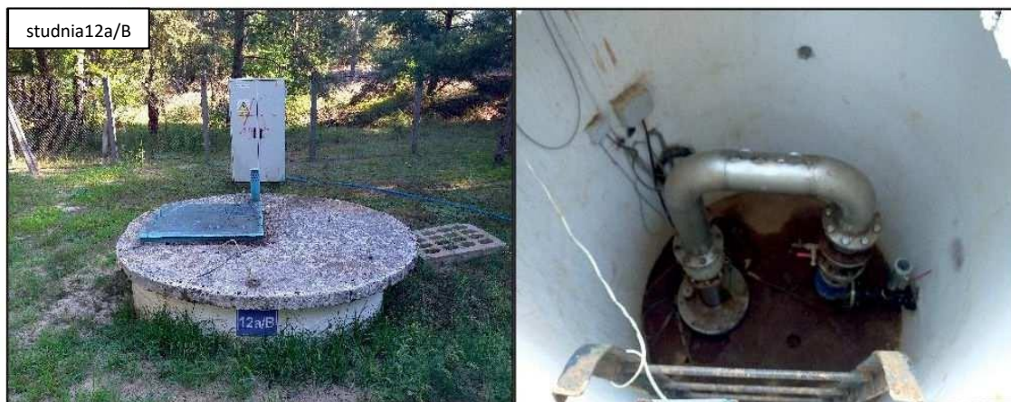
Fot. 1 Obudowa i armatura studni 12a/B
