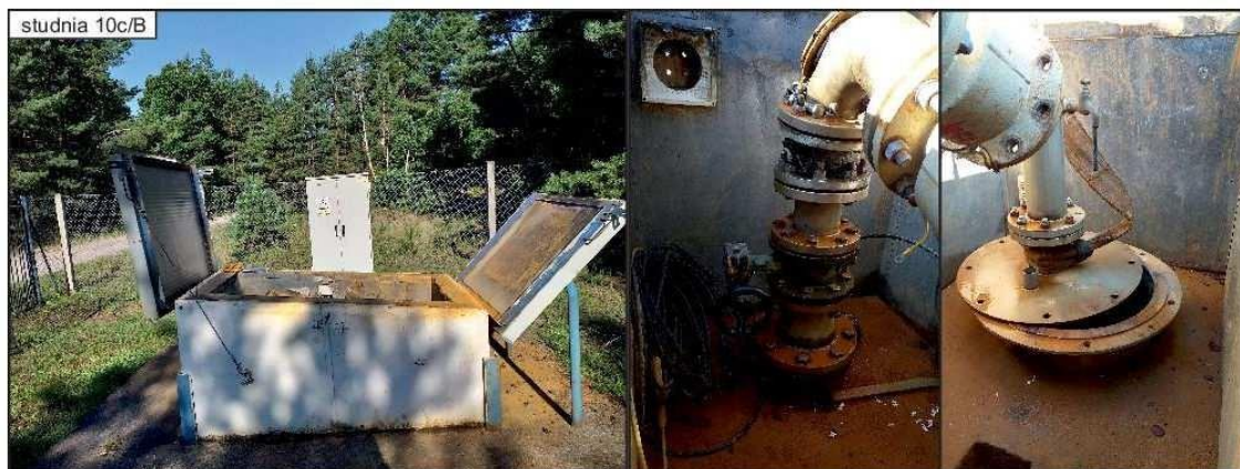
Fot. 2 Obudowa i armatura studni 10c/B
