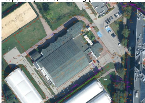
Zdjęcie nr 1 – Widok dachu hali sportowej
