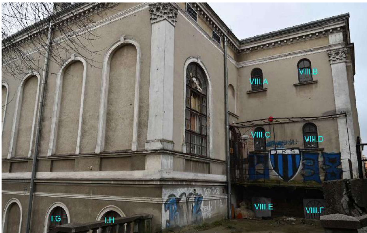
Dawny gmach Towarzystwa „Jad Charyjcy”, widok elewacji południowo-zachodniej z zaznaczonymi typami stolarki okiennej, styczeń 2024 r.
