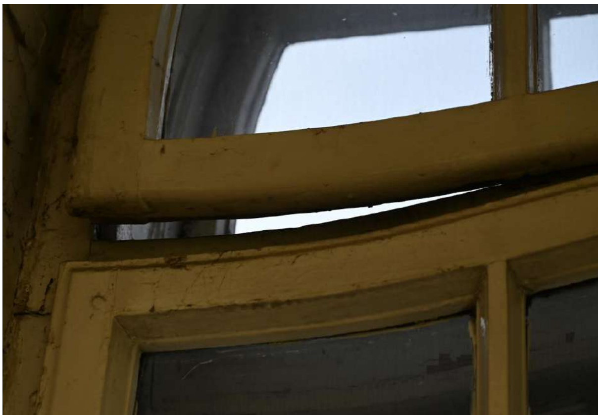
Fragment okna typu II (B), widoczne różnice w ramiakach i szprosach, styczeń 2024 r.
