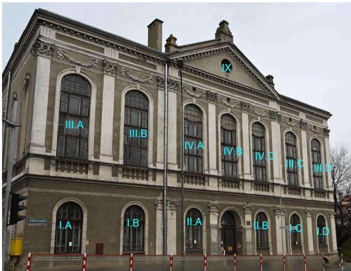
Dawny gmach Towarzystwa „Jad Charyjcy”, widok fasady z zaznaczonymi typami stolarki okiennej, styczeń 2024 r.
