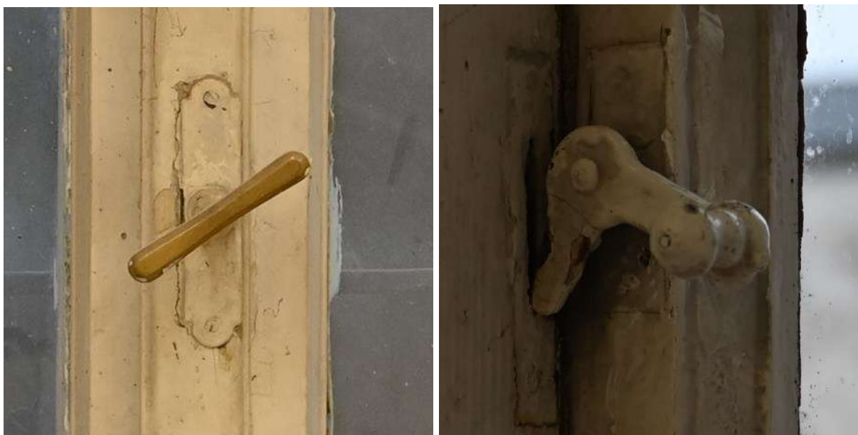
Oryginalne elementy metalowe zamykające okna – klameczka dwustronna oraz klameczka zatrzaskowa, styczeń 2024 r.
