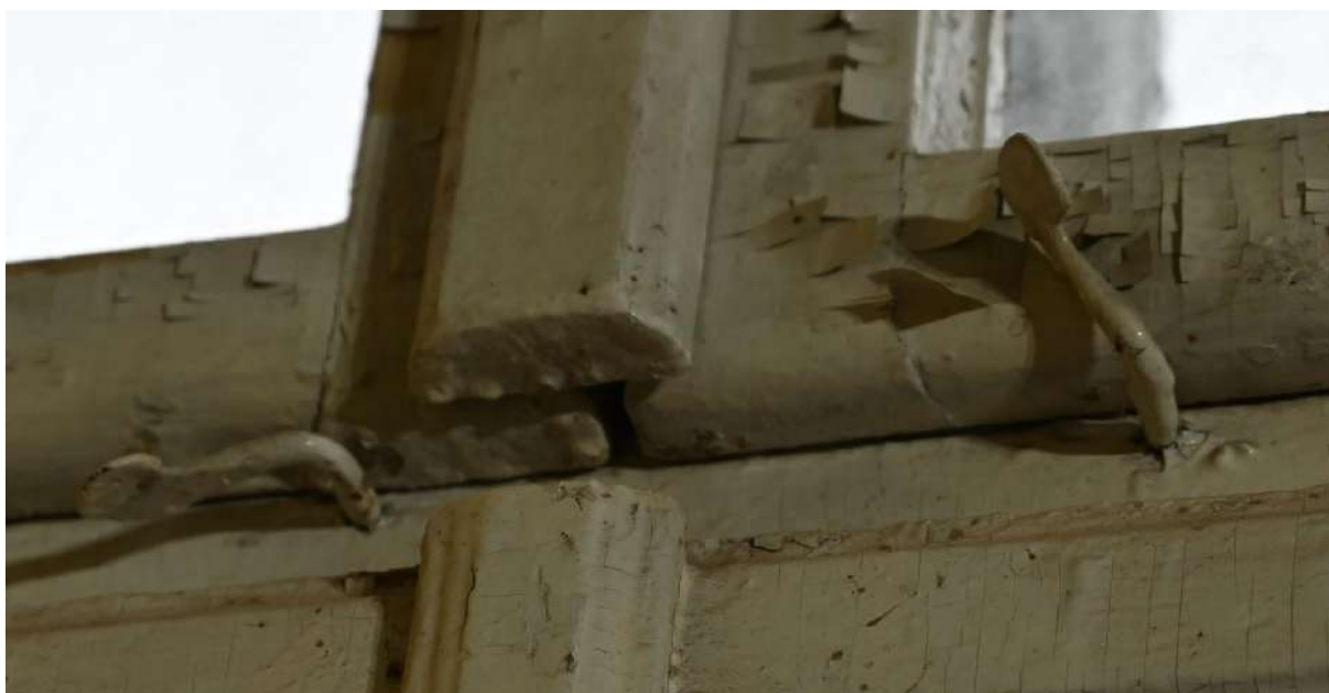
Oryginalne rygielki stosowane głównie przy skrzydłach stałych, demontowalnych, styczeń 2024 r.
