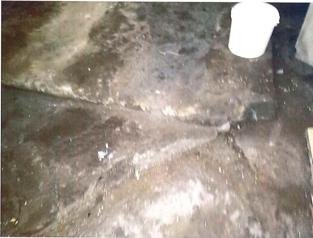
Foto 7 Posadzka byłej kotłowni- fundament pod piec
