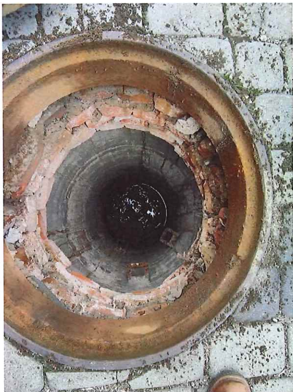
Foto 13 Studnia kanalizacji sanitarnej
