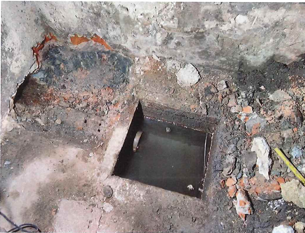
Foto 12 oczyszczona studzienka drenarska SD1
