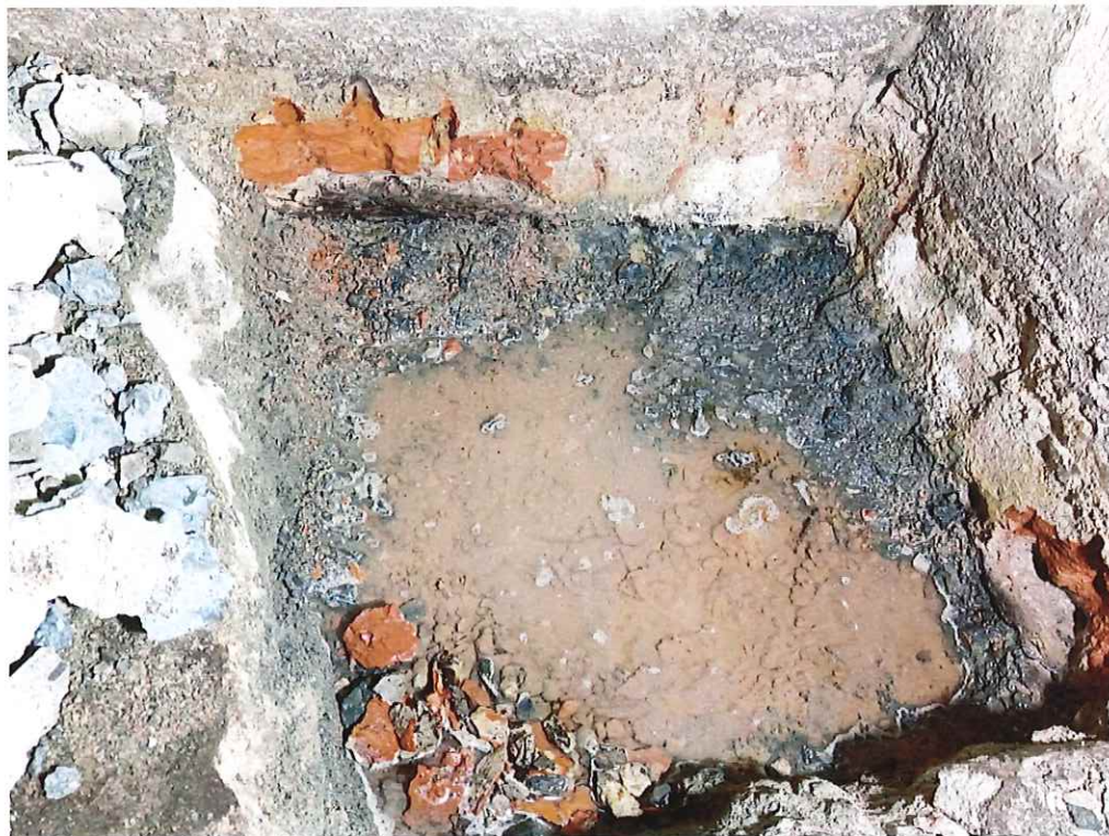
Foto 10 Odkrywka nr 3 przy ścianie zewnętrznej
