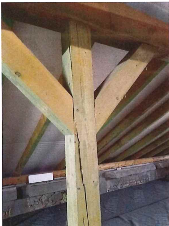
Foto 19 Spękanie słupa
