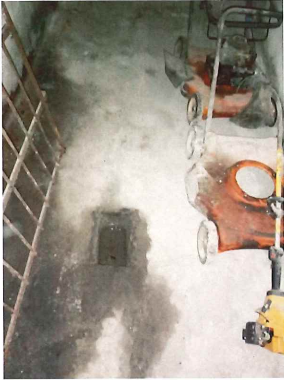
Foto 5 Pomieszczenie składu opału
