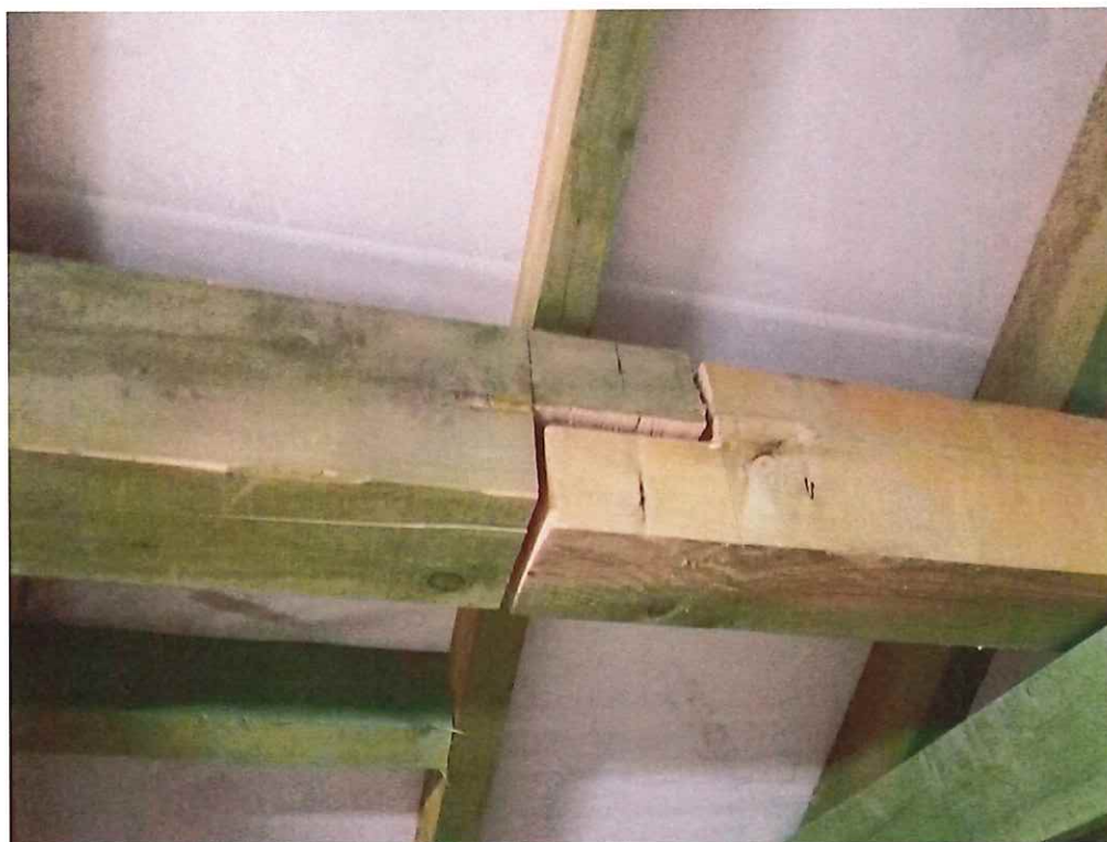
Foto 15 Połączenie płatwi pośrednich na zakład
