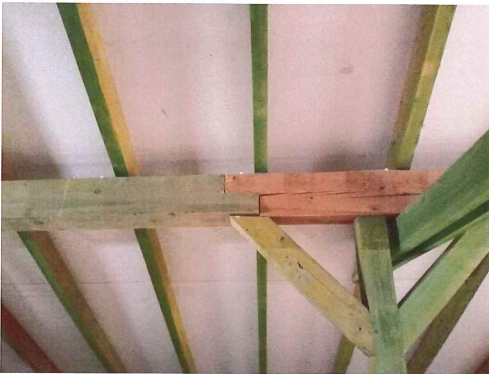
Foto 17 Spękania płatwi w połączeniu
