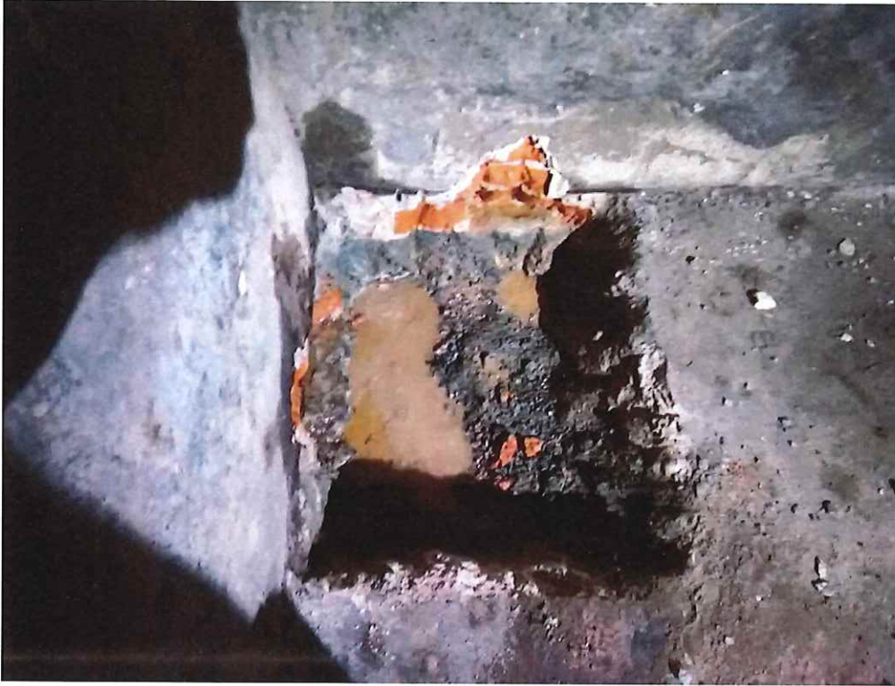
Foto 11 Rura drenarska pod posadzką piwnicy
