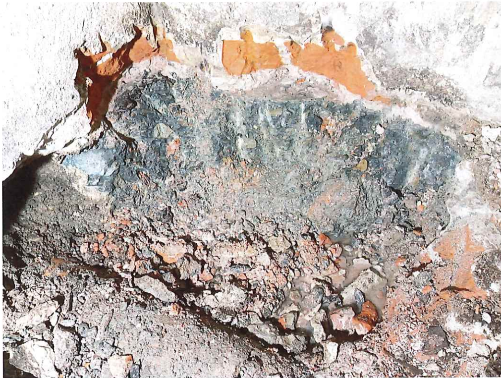
Foto 9 Odkrywka nr 2 ściany zewnętrznej w kotłowni
