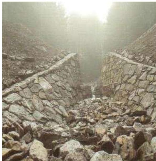
Przeplawka szczelinowa na suchym zbiorniku w I-ctwie Jawornica (fot. N-ctwo Międzylesie)
