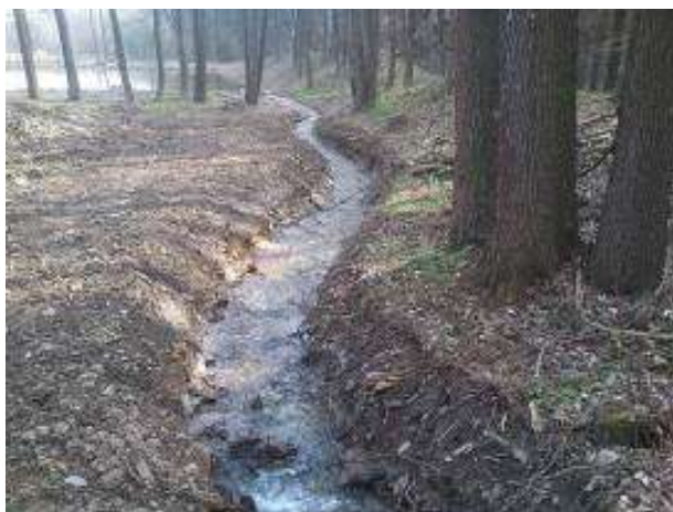
Kanał ziemny łączący 2 zbiorniki (N-ctwo Świdnica)
