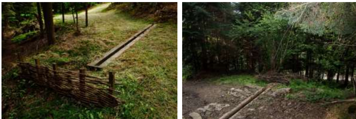
Płotki faszynowe antyerozyjne rozpraszające wodę na stok. Źródło: Archiwum CKPŚ.
