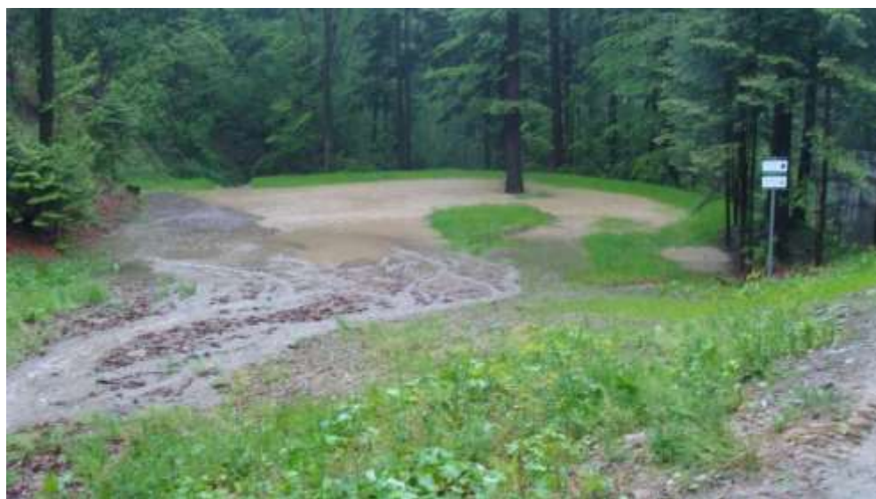
Zbiornik retencyjny na płyc powierzchniowy zaraz po wybudowaniu, dodatkowo zasilany wodą spływającą z leśnej drogi – Nadleśnictwo Piwniczna. Źródło: zasoby własne Nadleśnictwa Piwniczna
