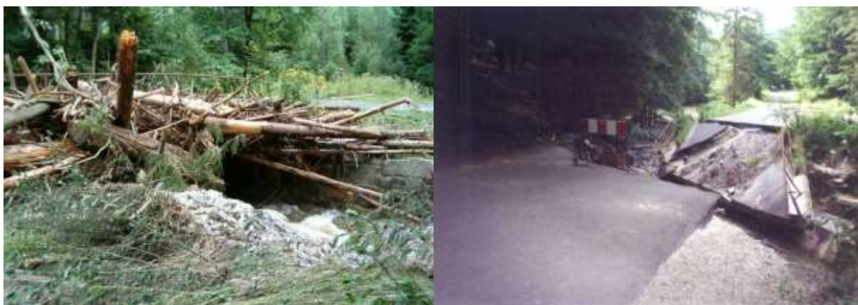
Rumosz niesiony wodą w czasie katastrofalnego wezbrania osadzony na moście. Źródło: Archiwum CKPŚ. Zerwany most w Nadleśnictwie Łądek Zdrój. Źródło: Archiwum CKPŚ.
