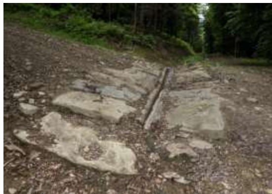
Wodospust odprowadzający wodę z drogi do lasu.
