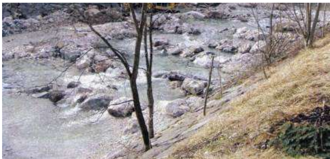
Bystrze kaskadowe typu „plaster miodu” (fot. M. Ulmer)
