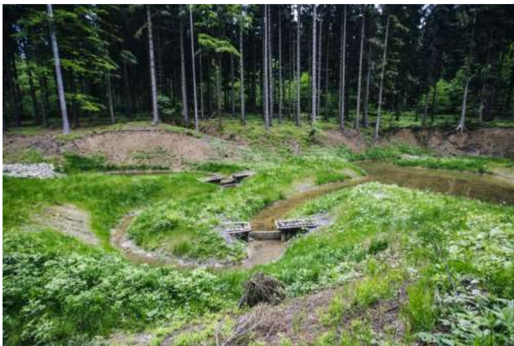
Zatoka zastoiskowa i zastawki na cieku – Nadleśnictwo Międzylesie. Źródło: Archiwum CKPŚ.
