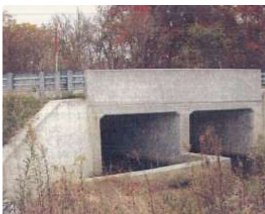
Przykłady ścianek ukierunkowujących niski przepływ do jednej komory przepustu (przepust dwukomorowy na zdjęciu i trzykomorowy na rysunku). Źródło: „Metody hydraulicznego projektowania przepustów z uwzględnieniem morfologii ciek i wymogów związanych ze swobodnym przepływem ryb.” A.J. Kosicki w „Hydraulika, hydrologia, hydrogeologia”, rys. na podstawie źródła P. Włodarczyk.
