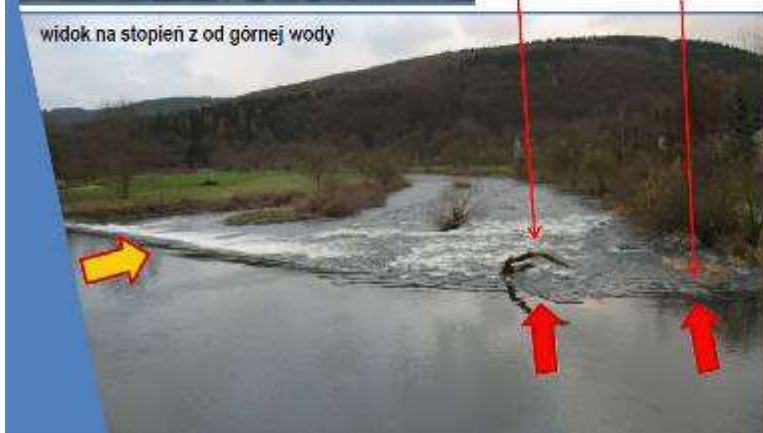
Bystrze dwuspadowe na stopniu poniżej mostu (Jelonek 2008)
