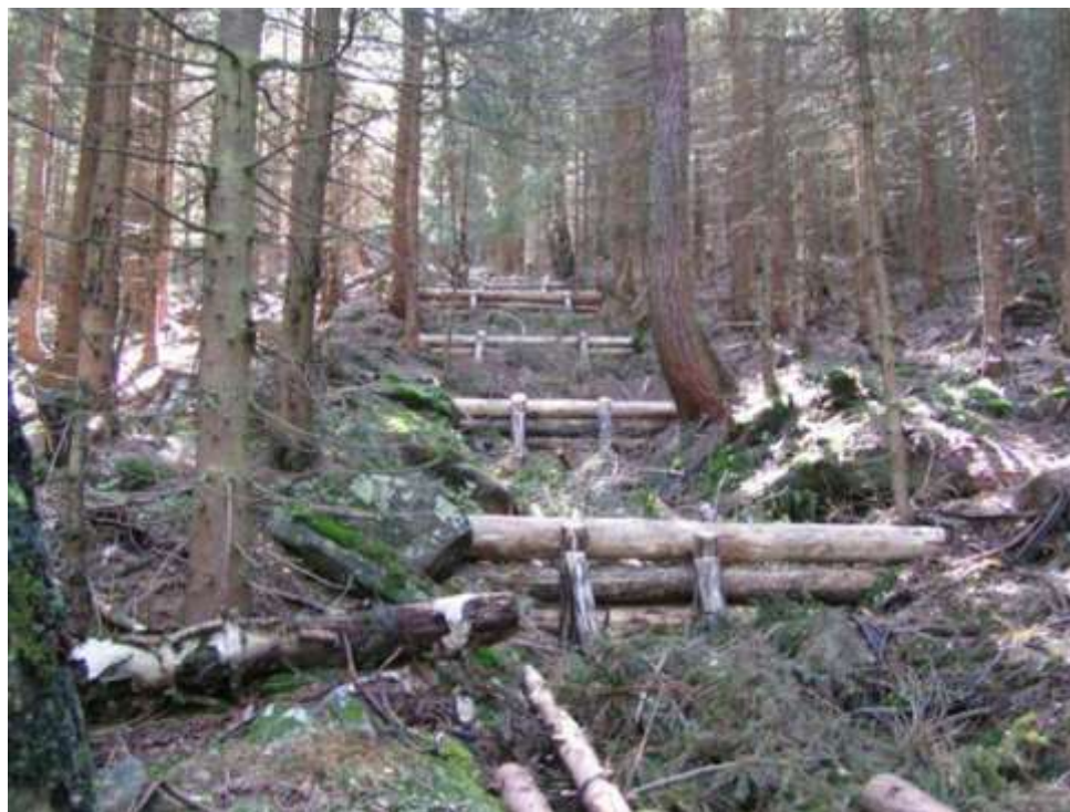
Przegrody drewniane wypełnione gałęziówką na szlakach zrywkowych
