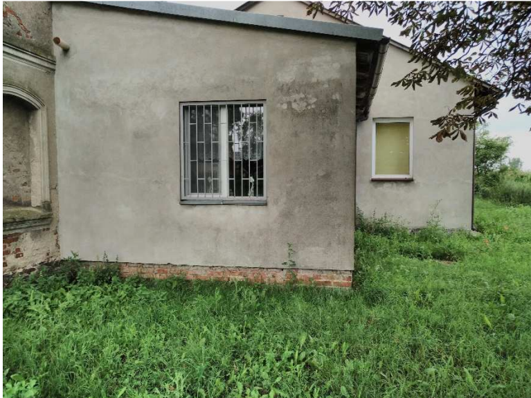
Zdjęcie 8 Kraty w oknie do usunięcia, okno w części nowej do zamurowania
