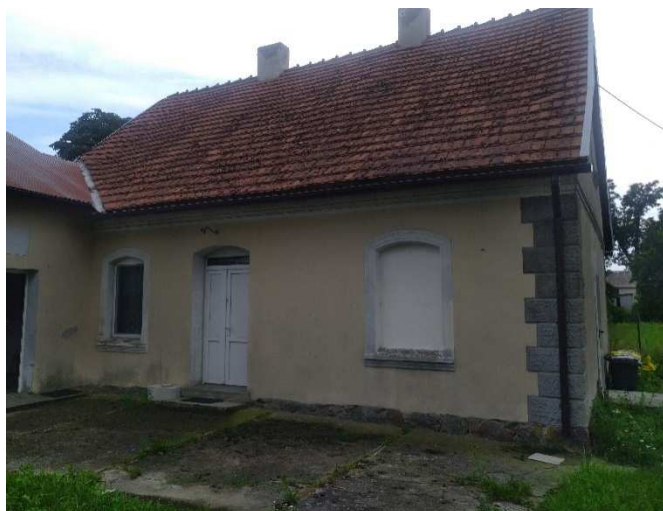
Zdjęcie 1 W starym budynku w trakcie ocieplania do odtworzenia gzymsy, cokół oraz kamień na narożach budynku, kominy od wysokości połaci dachu do przemurowania
